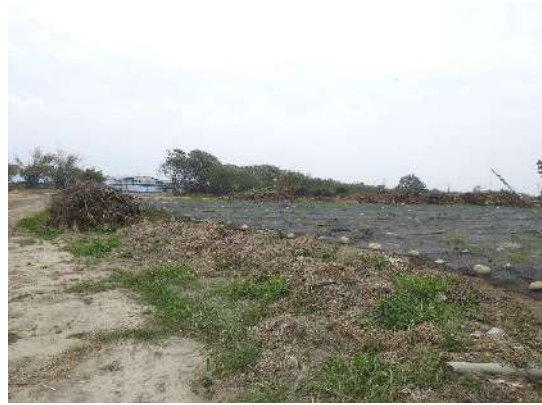
2/28 已清除部分進行防塵網覆蓋，避免揚塵
