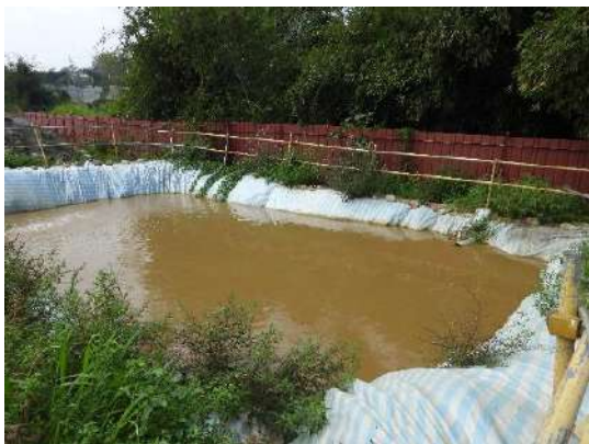
2/29 滯洪沉砂池水質混濁與滯洪沉砂池排出貓羅溪支流造成水質混濁
