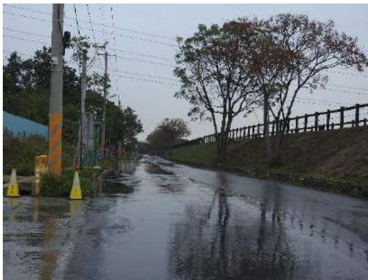
工區周圍進行洗掃(1/25)
