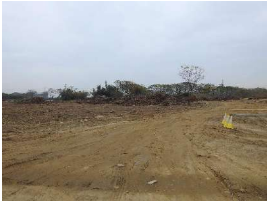
1/25 荔枝園(位於汙泥濃縮池位置)清除
