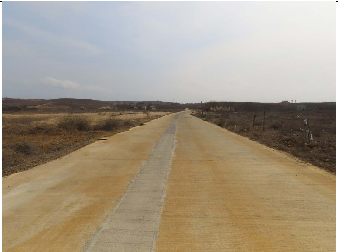
輸水管工程已完成部份 (112.3.16)
