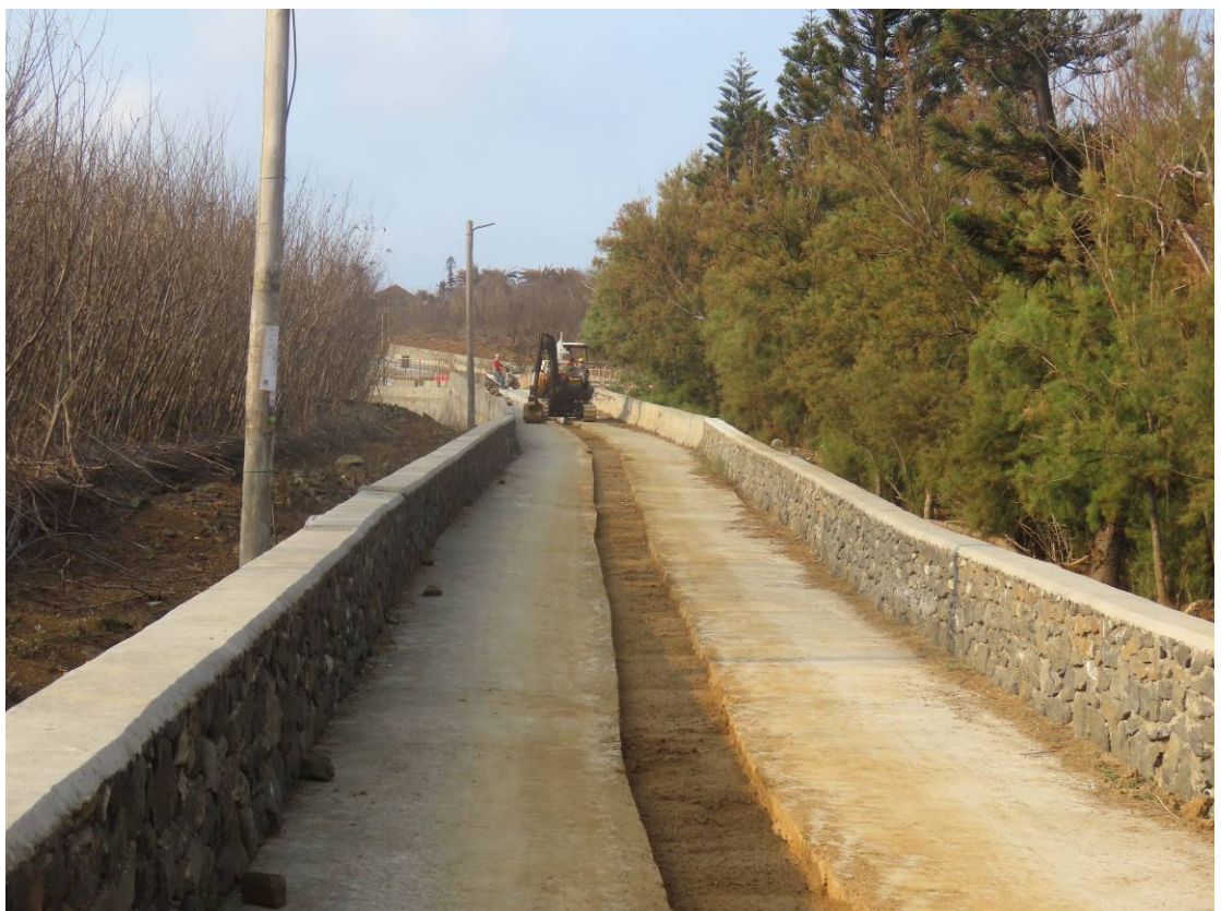
輸水管工程位於水庫道路部份 (112.3.17)
