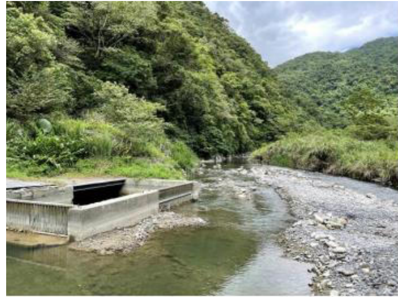
第二取水口(高程約106m)
