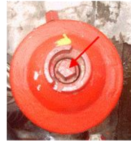
測量標的：消防栓 測點位置：消防栓頂方型柱中心點
