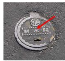
測量標的：圓型 制水閘 測點位置：人孔中央[制水閘箱] 方形標示[水]字中央處
