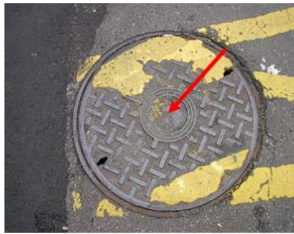
測量標的：自來水圓形 人孔 測點位置：人孔中央[台水]圓形交叉點
