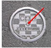
測量標的：圓型 制水閘 測點位置：人孔中央菱型標式 對角線交叉點
