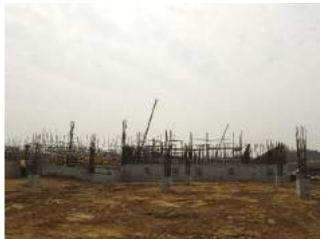
西側淨水單元-快濾池(3/31)
