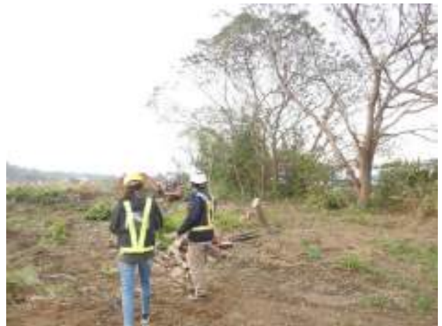
與施工團隊確認保全對象周圍施工(1/15)
