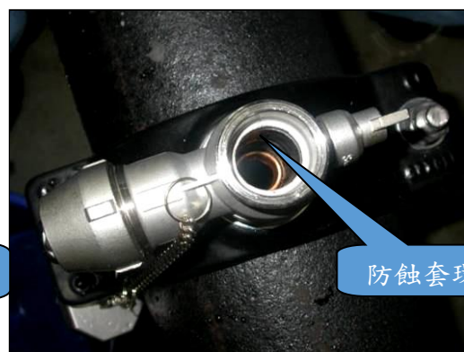
(防蝕套環裝置完成)
