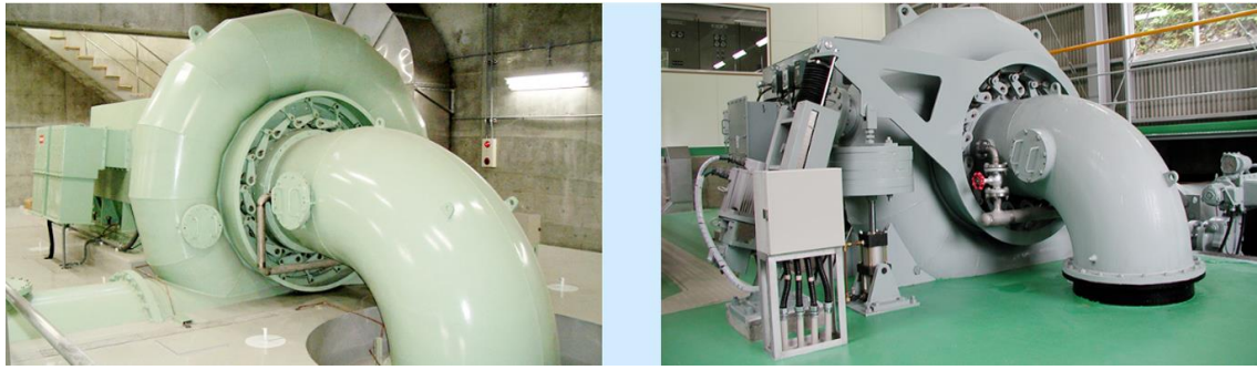
圖 3-6、法蘭西斯式水輪機示意圖
