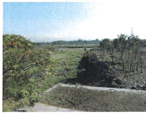
10. 廢水放流預定地之排水道
