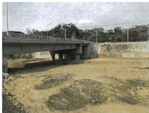
8. 已完工之聯外橋樑工程形成之裸露地
