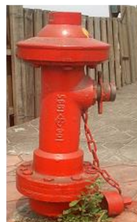
測量標的：消防栓 測點位置：消防栓頂方型柱中心點
