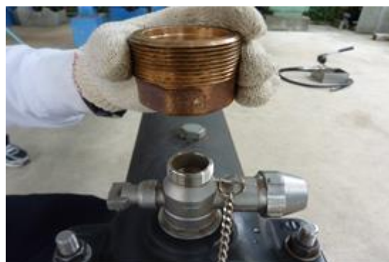
(安裝接合器於鞍帶分水栓上)
