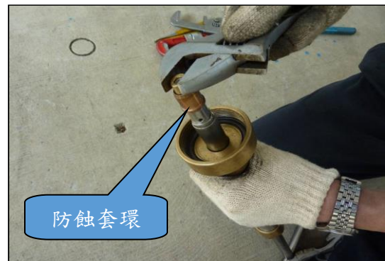
(十字鑽孔機裝置及施工)
