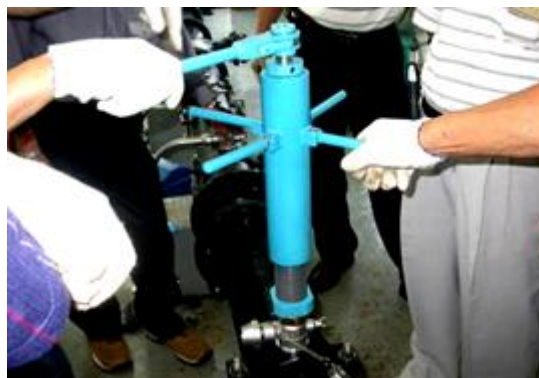
(十字鑽孔機裝置及施工)
