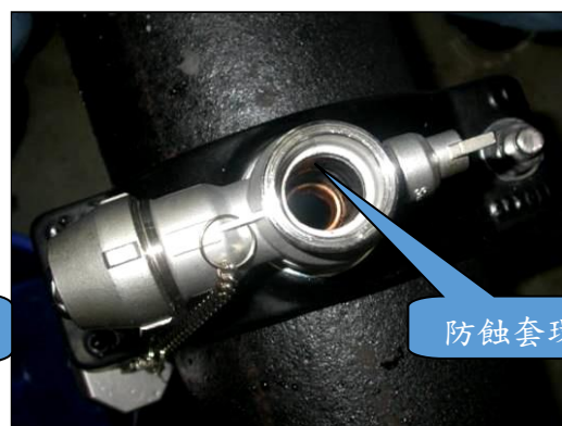
(防蝕套環裝置完成)
