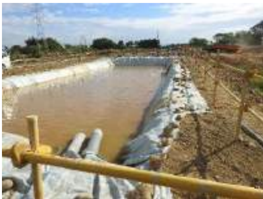
11/30 滯洪沉砂池水質混濁與滯洪沉砂池排出貓羅溪支流造成水質混濁
