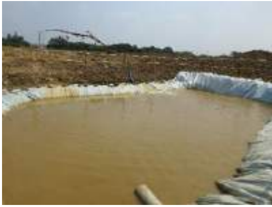
10/25 滯洪沉砂池水質混濁與滯洪沉砂池排出貓羅溪支流造成水質混濁
