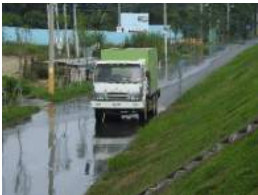
工區周圍進行洗掃(10/26)
