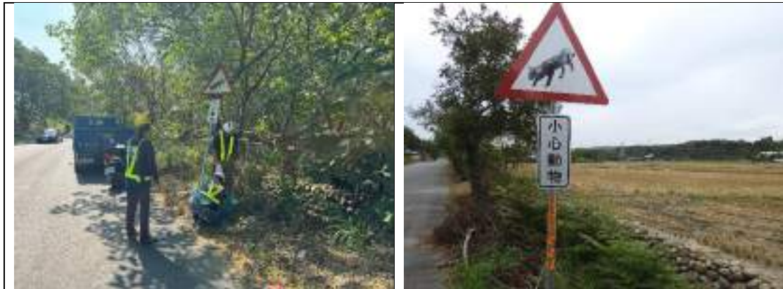
設置警示標誌
