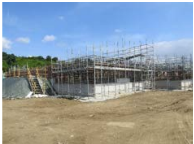
西側淨水單元-膠泥池(6/26)
