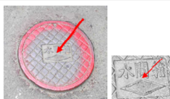
測量標的：圓型制水閘 測點位置：人孔中央[水箱閘◇] 上方轉折點
