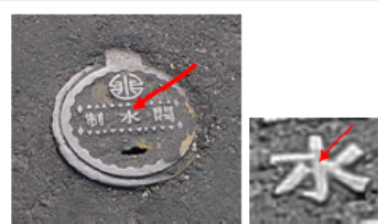
測量標的：圓型制水閘 測點位置：人孔中央[制水閘箱] 方形標示[水]字中央處
