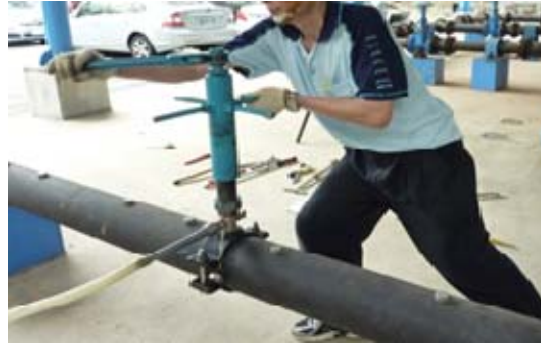
(十字鑽孔機施工及排水)
