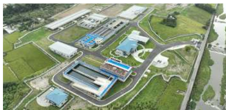
草屯淨水場新建工程完工
