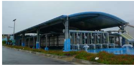
澎湖馬公烏坎 3000 噸海水淡化廠完工啟用
