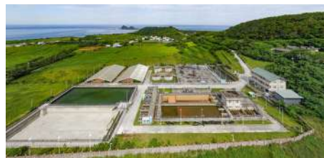
台東新設成功淨水場工程完工
