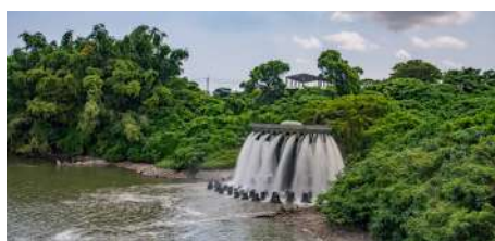
鳳山水庫竣工
