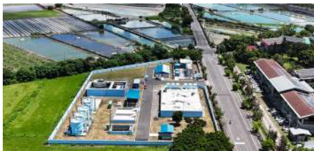
屏東鹽埔淨水場新建工程 - 土建完工
