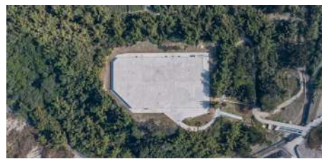
深水高地配水池重建工程完工
