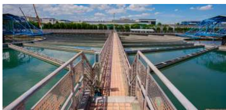
鯉魚潭淨水廠第一期淨水設備完工
