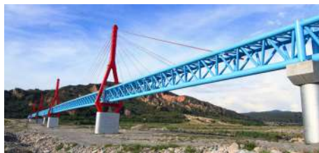
大安溪新設水管橋工程完工
