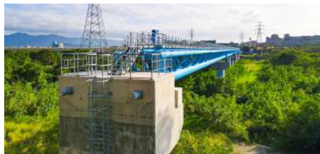
新設後龍溪北勢橋水管橋工程完工
