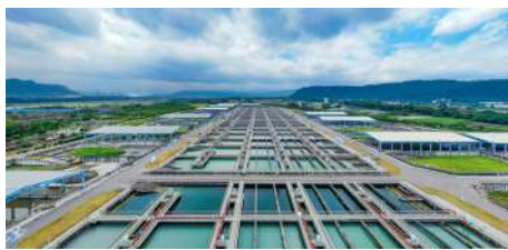
湖山水庫下游自來水工程 - 前處理設備完工
