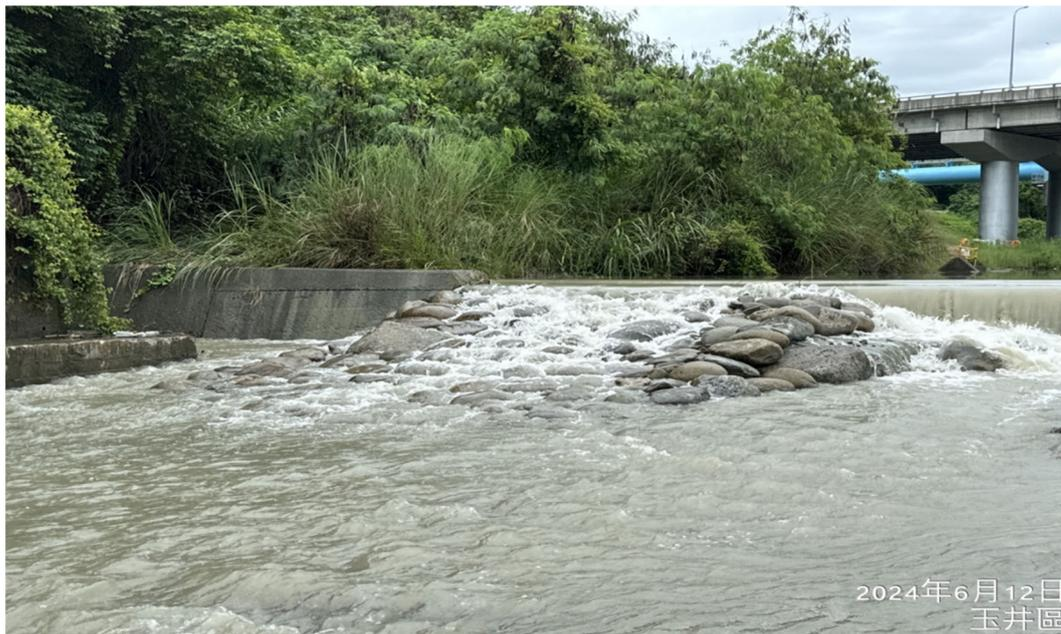
圖 4-13 公路橋攔沙壩下游設置拋塊石式魚梯完成(照片由瑞鋒公司提供)
