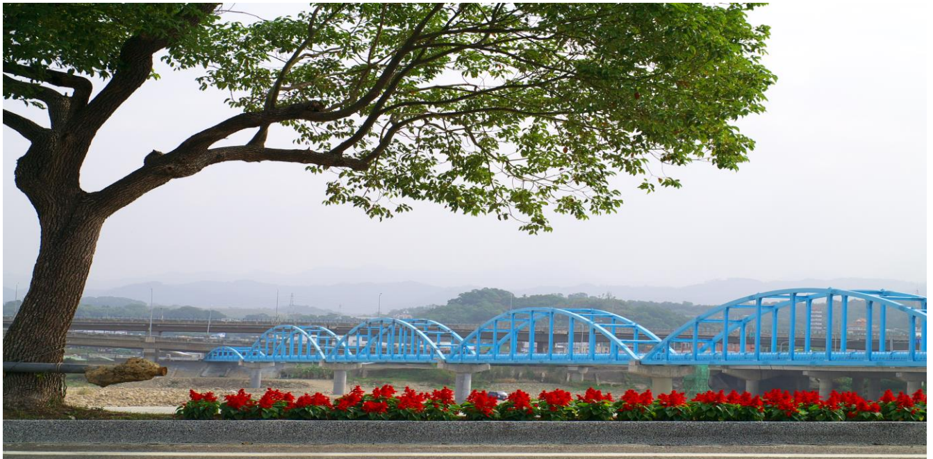
苗栗頭屋水管橋
