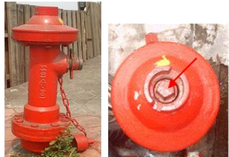
測量標的：消防栓 測點位置：消防栓頂方型柱中心點
