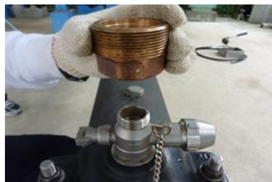
(安裝接合器於鞍帶分水栓上)
