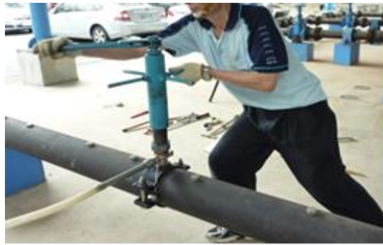
(十字鑽孔機施工及排水)
