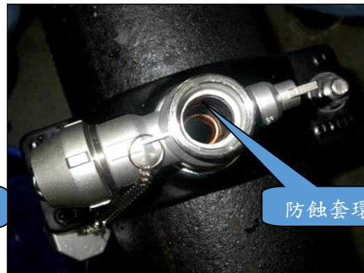
(防蝕套環裝置完成)
