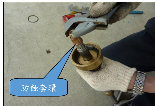
(十字鑽孔機裝置及施工)
