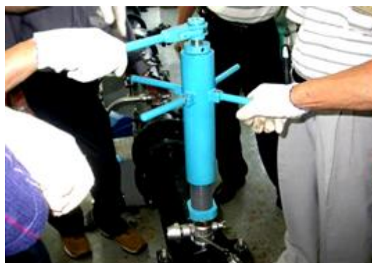
(十字鑽孔機裝置及施工)
