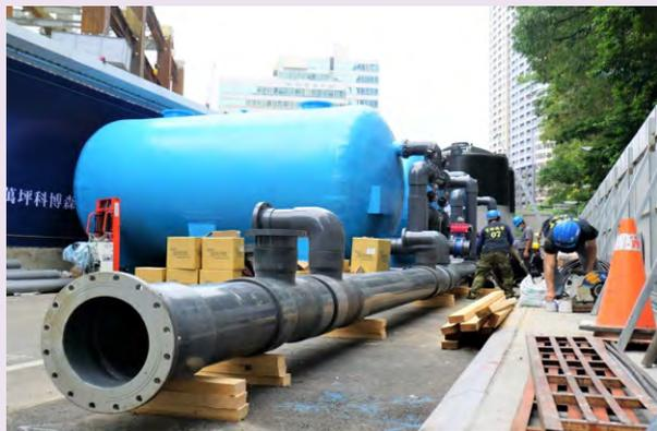
▲ 圖 2-16 台中老佛爺建築工地取水管線組裝
