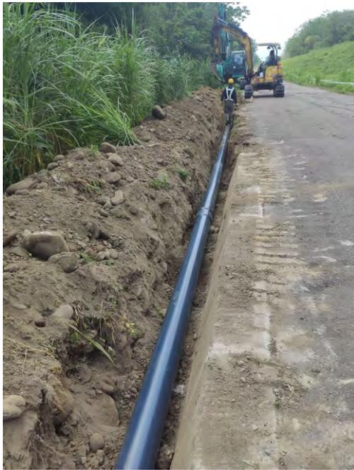
▲圖 2-22 頭前溪沿線新設抗旱井管線埋設
