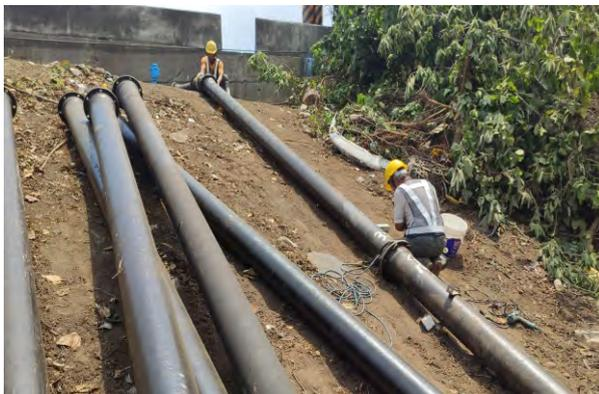
▲圖 2-24 芎林新設抗旱井連接既有原水管
