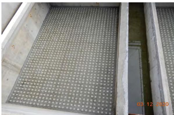
▲圖 2-21 快濾池系統試車曝氣測試
