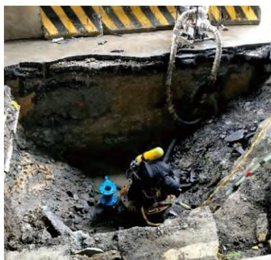
▲ 圖 5-44 SP1200mm 管內45度鋼管水中焊接
