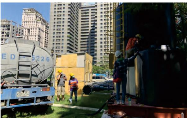
▲ 圖 4-59 台中商銀總部建築工地地下水儲藥槽添補次氯酸鈉
