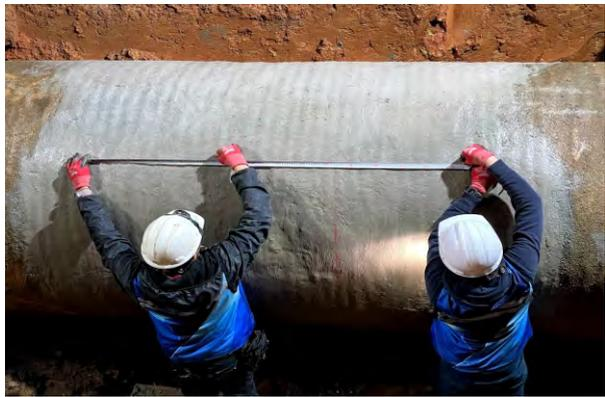
▲圖 2-39 漏水管線搶修
