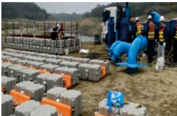
▲ 圖 4-20 永和山水庫呆水位架設浮筒抽水整備
