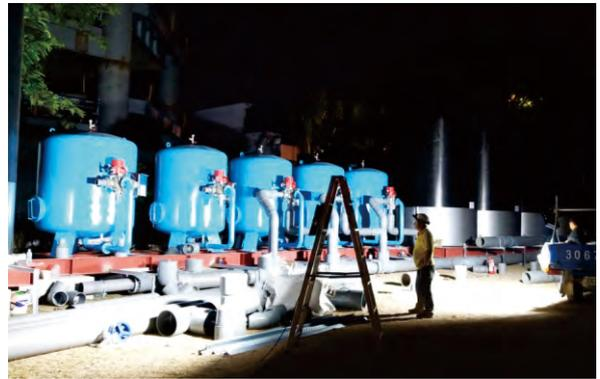
▲圖 5-38 台中商銀建築工地夜間安裝快濾桶系統
