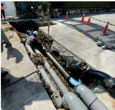
▲ 圖 5-35 台中勤美之森建築工地原水管線埋設
