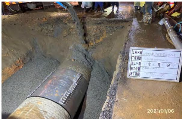
▲圖 2-41 安裝完成回填級配及水泥灌漿
