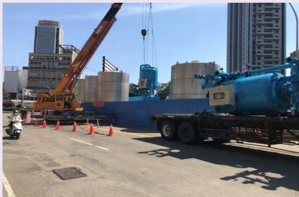
▲ 圖 2-17 台中仰星殿建築工地快濾桶設備吊裝
