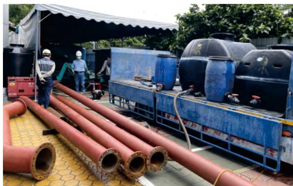
▲ 圖 4-60 惠民三建築工地地下水使用儲藥槽添補次氯酸鈉
