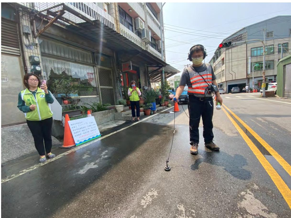
▲ 圖 2-50 漏水檢測
