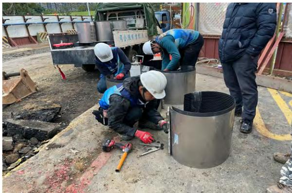
▲圖 2-40 管線外部整平及放樣作業
