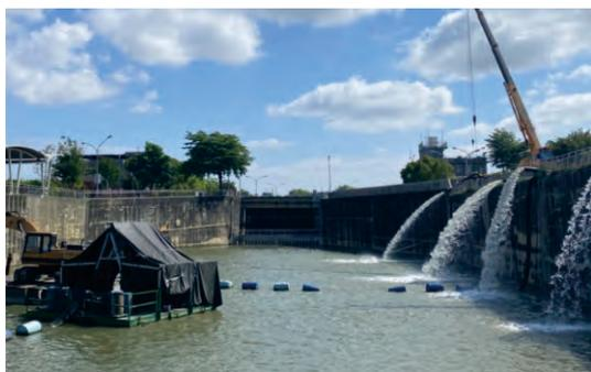
▲ 圖 4-102 高屏溪沉沙池鄰近地下水抽水
