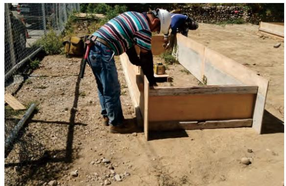
▲圖 5-40 台中築願景建築工地基礎模板施工
