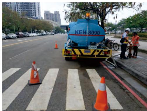
▲ 圖 5-58 水車臨時供水作業取水作業
