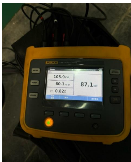
圖 12 第二配電室 M2 100HP 沉水式抽水機量測當量
