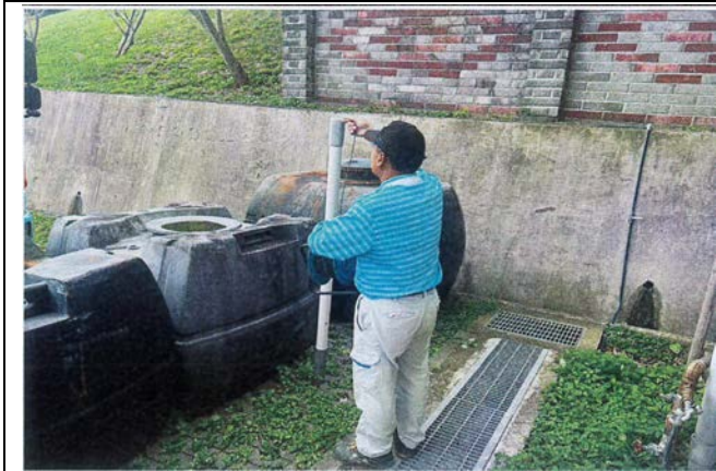
傾斜管觀測-水位量測(115.02.25)
