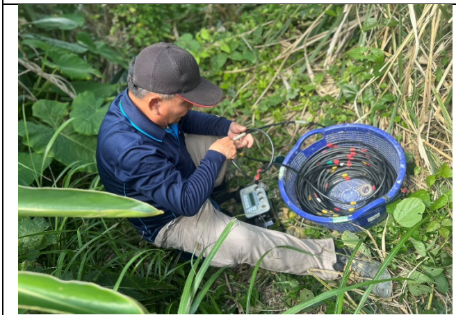
傾斜管觀測-量測(115.03.31 地震後)
