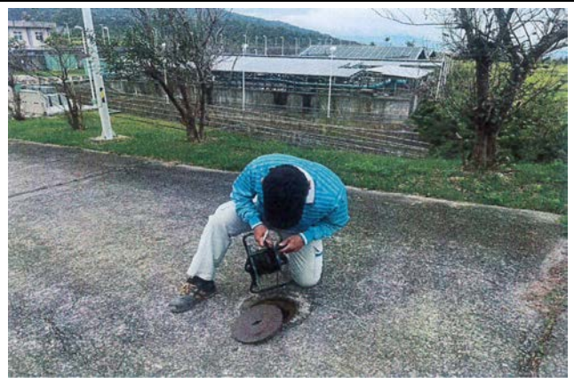
傾斜管觀測-水位量測(115.02.25)
