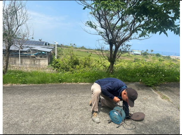
傾斜管觀測-水位量測(115.03.31地震後)
