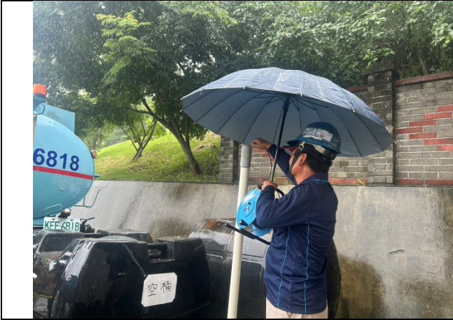
傾斜管觀測-水位量測(115.05.15 地震後)
