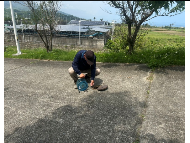
傾斜管觀測-水位量測(115.05.26 地震後)
