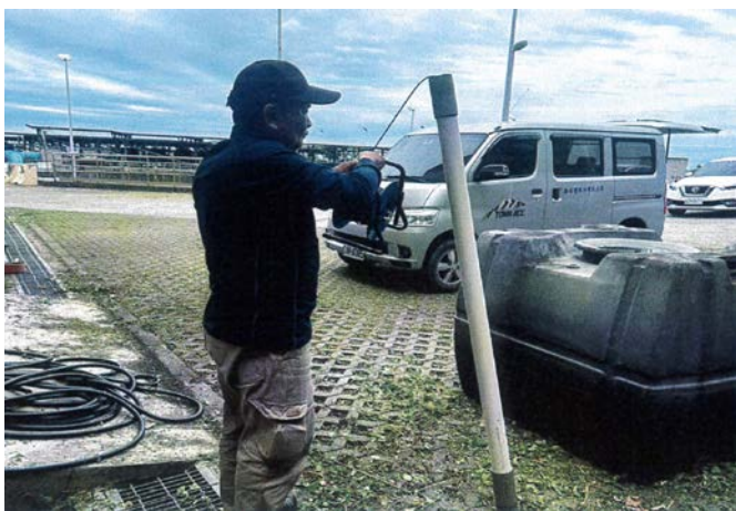
傾斜管觀測-水位量測(115.05.05)
