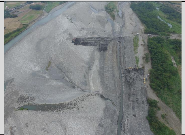
河道施工土方挖掘 113.12.23
