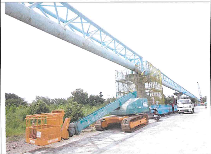
輸水管路線現況
