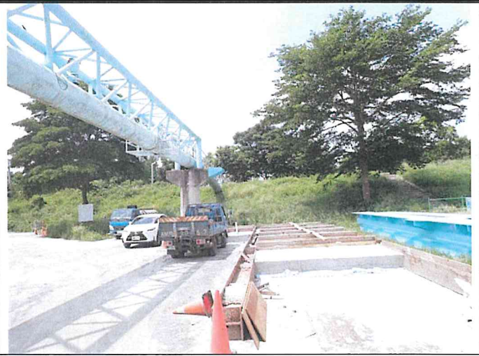
輸水管路線現況
