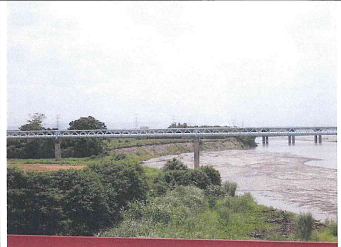
輸水管路線現況
