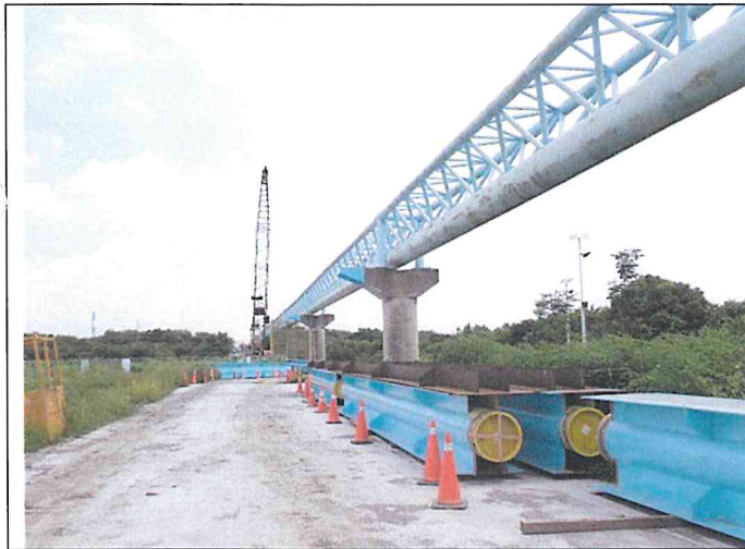
輸水管路線現況
