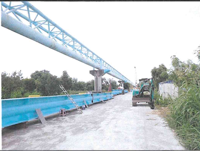
輸水管路線現況
