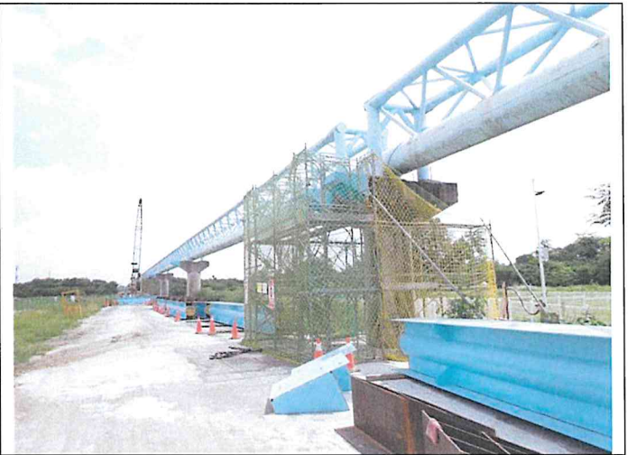
輸水管路線現況
