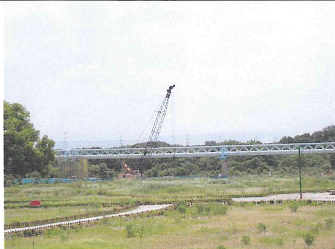
輸水管路線現況
