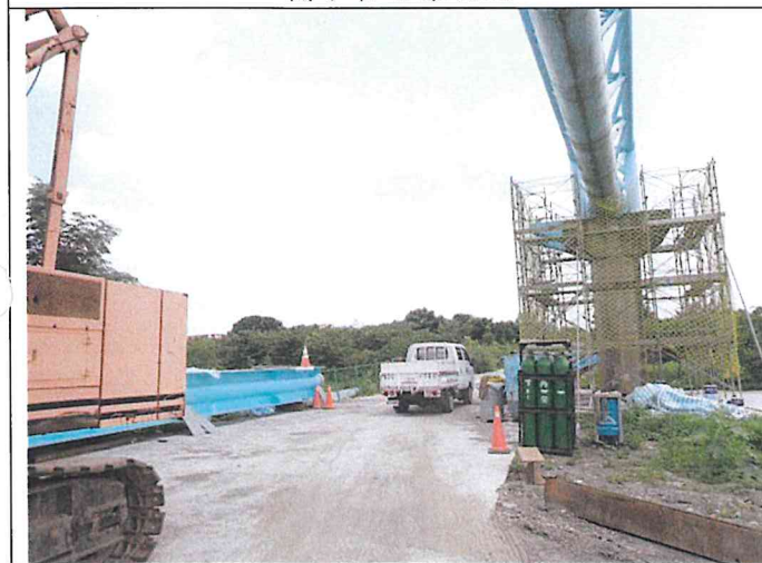
輸水管路線現況
