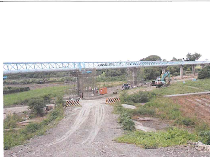
輸水管路線現況
