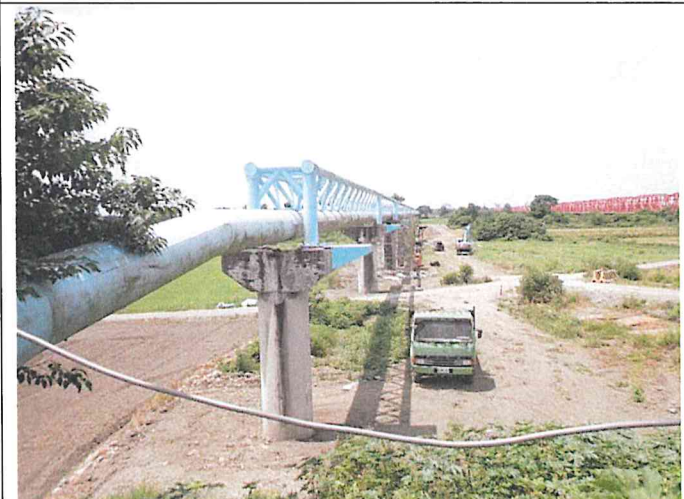
輸水管路線現況
