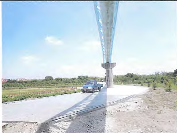
輸水管路線現況
