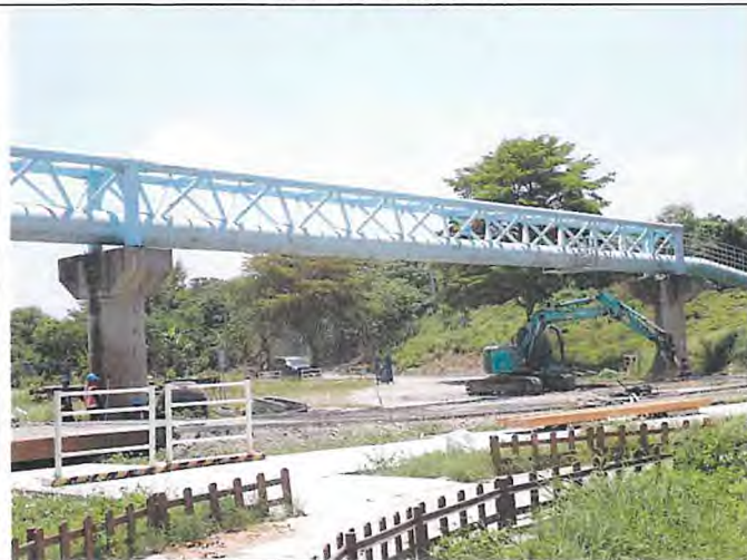
輸水管路線現況
