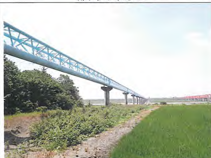
輸水管路線現況
