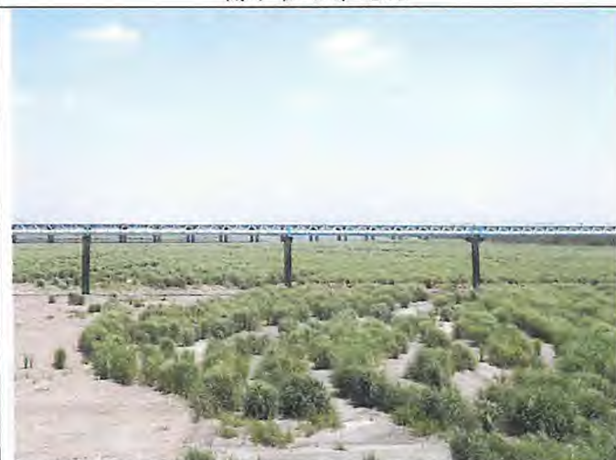
輸水管路線現況
