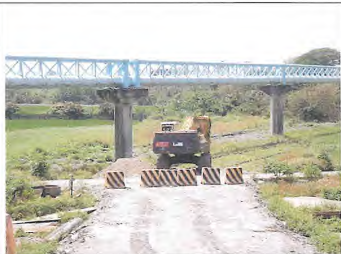
輸水管路線現況
