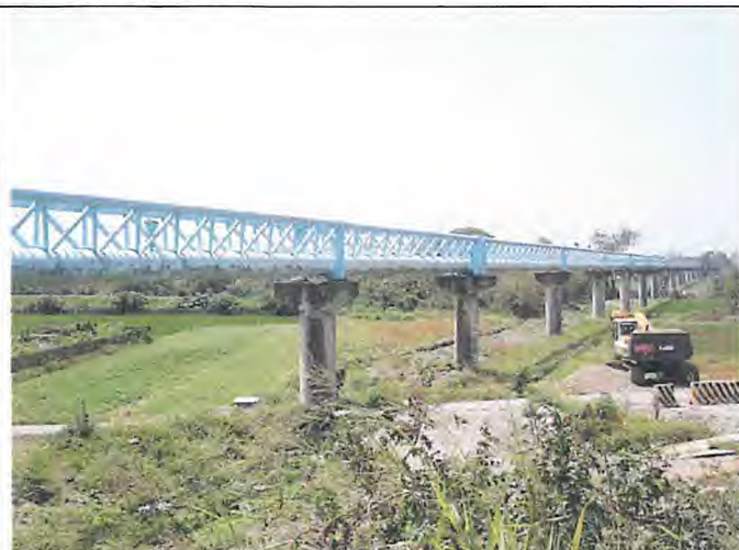
輸水管路線現況
