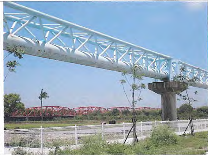
輸水管路線現況
