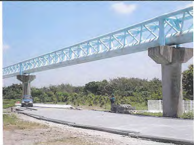
輸水管路線現況
