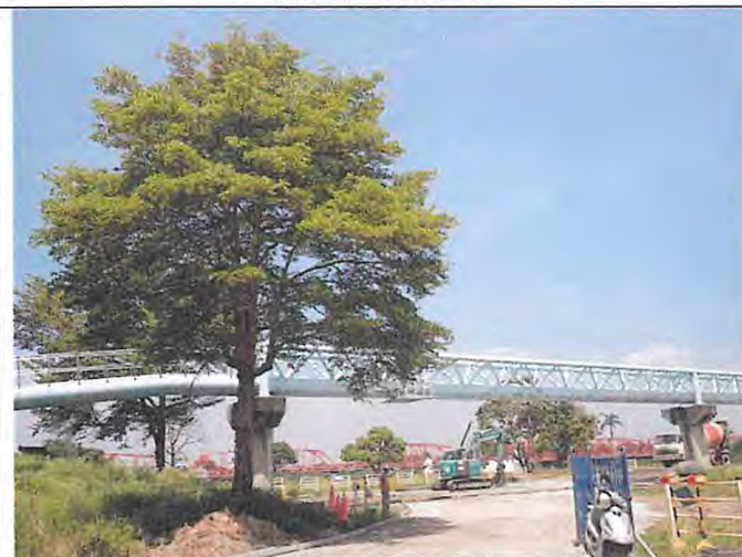
輸水管路線現況
