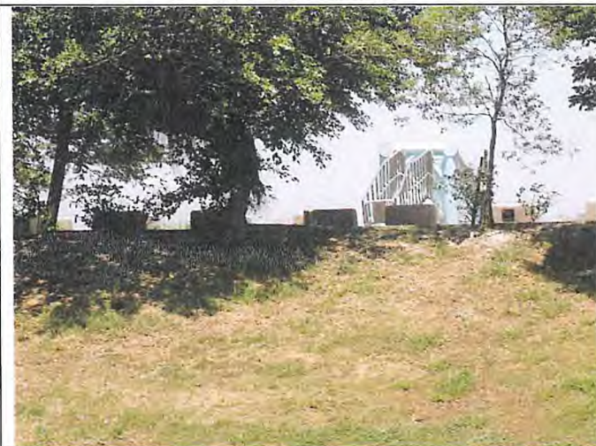
輸水管路線現況
