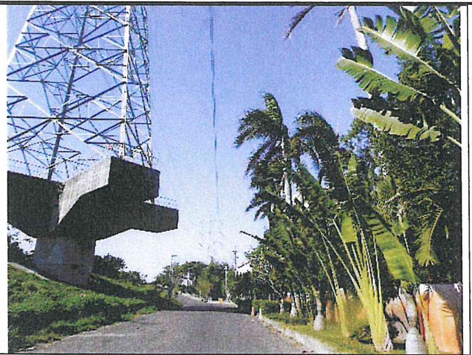
輸水管路線現況
