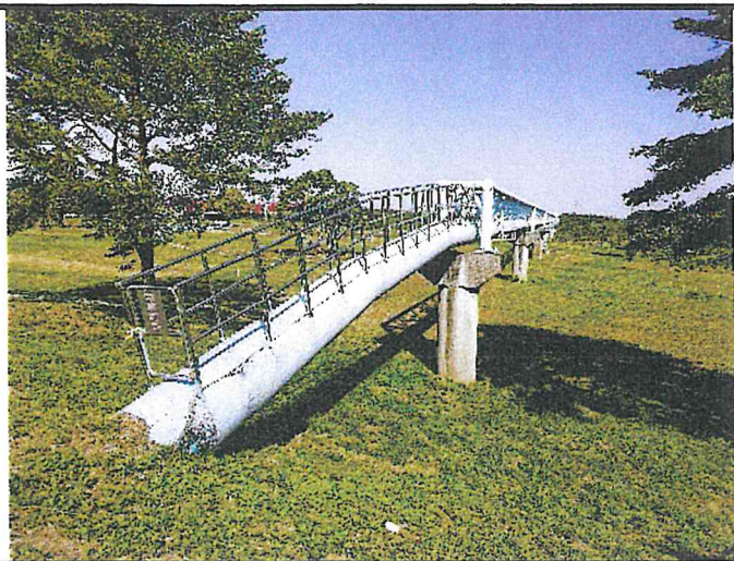
輸水管路線現況
