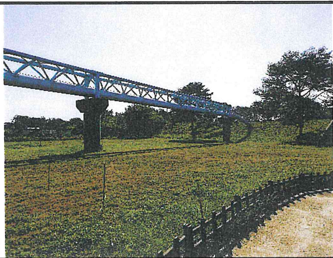
輸水管路線現況
