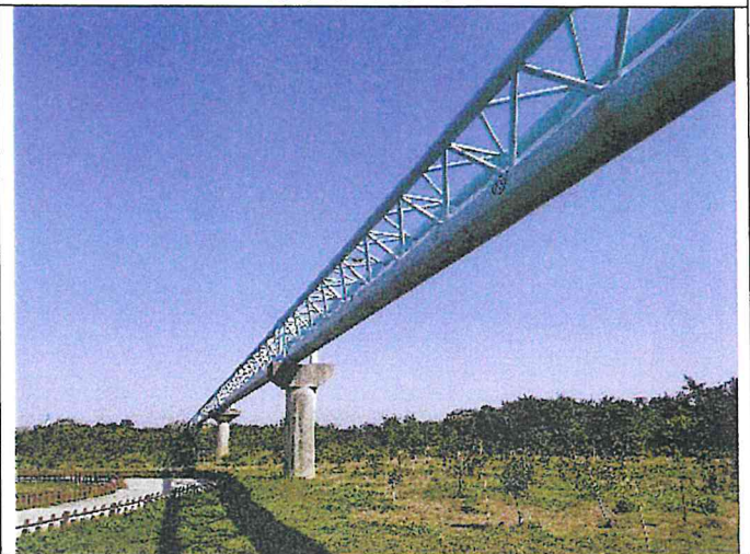
輸水管路線現況
