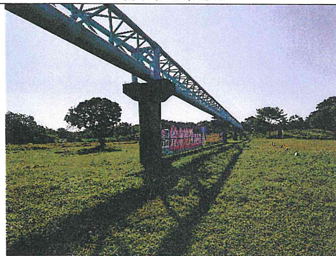
輸水管路線現況
