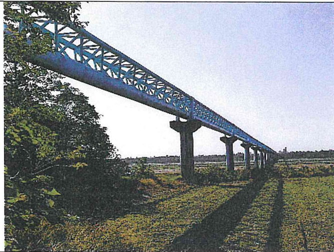
輸水管路線現況
