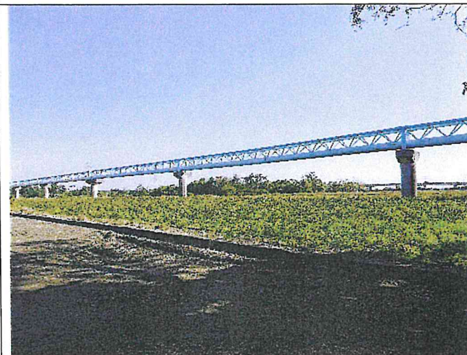
輸水管路線現況
