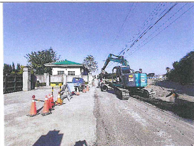
輸水管路線現況
