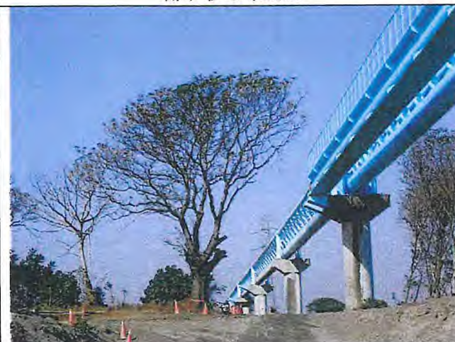
輸水管路線現況
