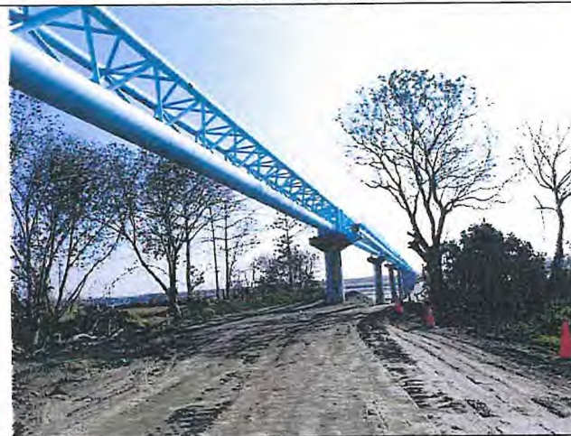
輸水管路線現況
