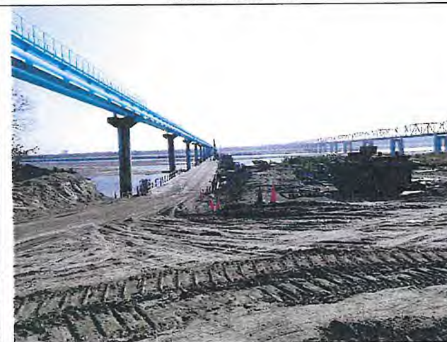
輸水管路線現況
