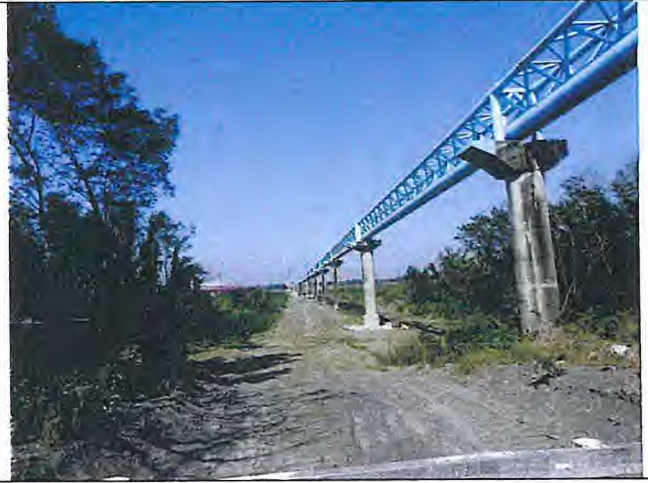
輸水管路線現況
