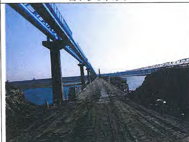
輸水管路線現況
