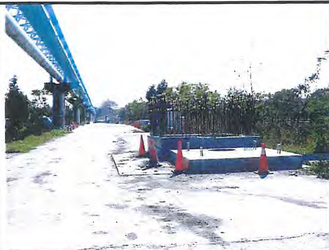
輸水管路線現況
