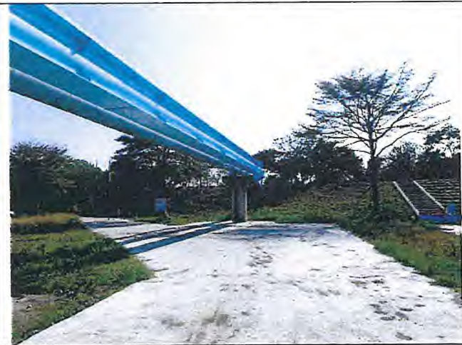
輸水管路線現況
