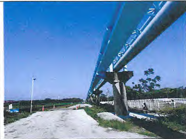
輸水管路線現況
