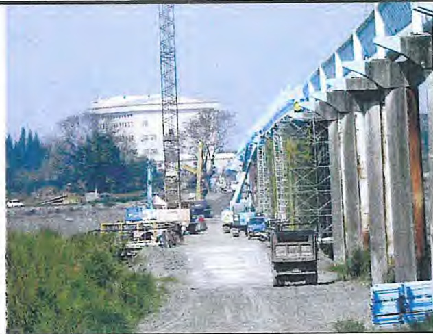
輸水管路線現況
