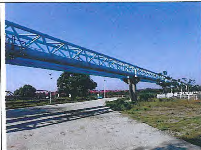
輸水管路線現況
