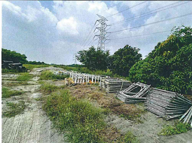
輸水管路線現況
