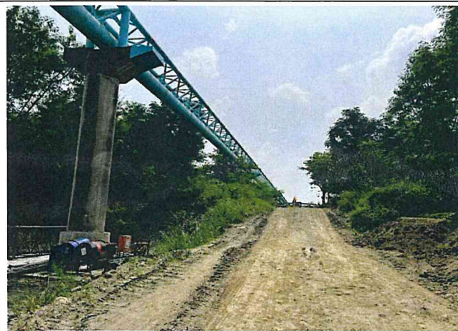
輸水管路線現況
