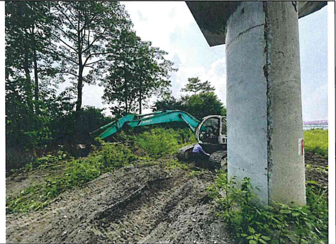
輸水管路線現況
