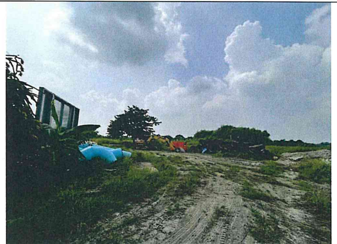
輸水管路線現況
