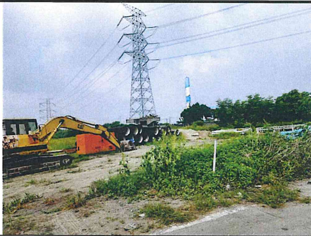
輸水管路線現況
