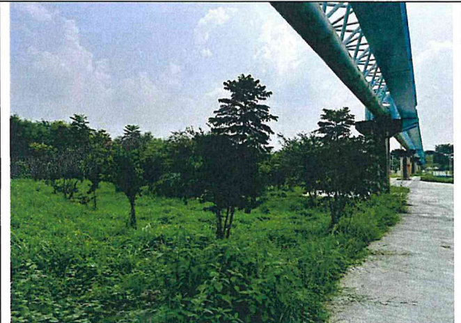
輸水管路線現況
