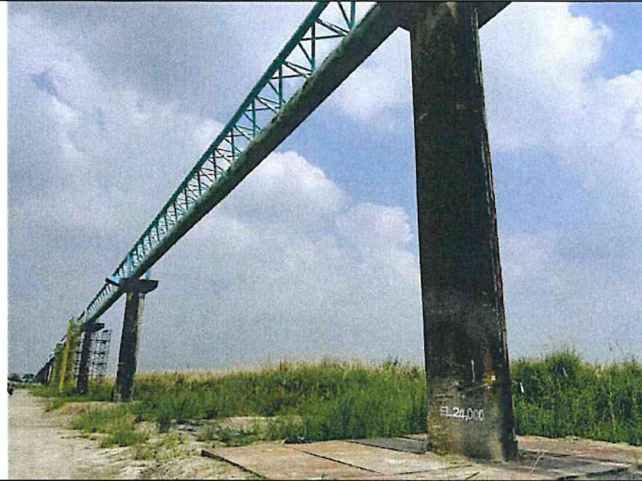
輸水管路線現況
