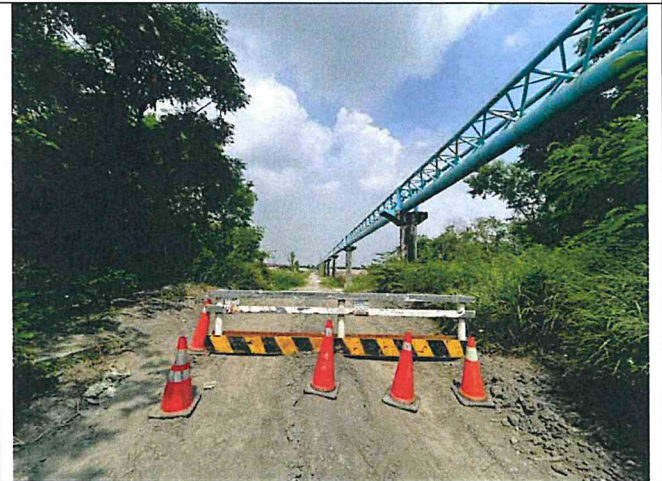
輸水管路線現況
