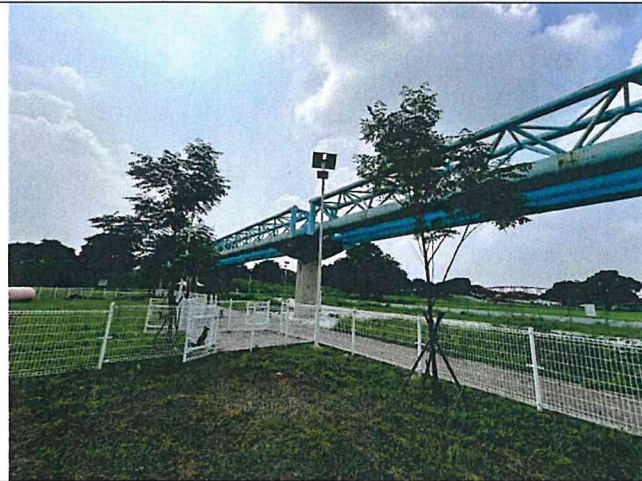
輸水管路線現況
