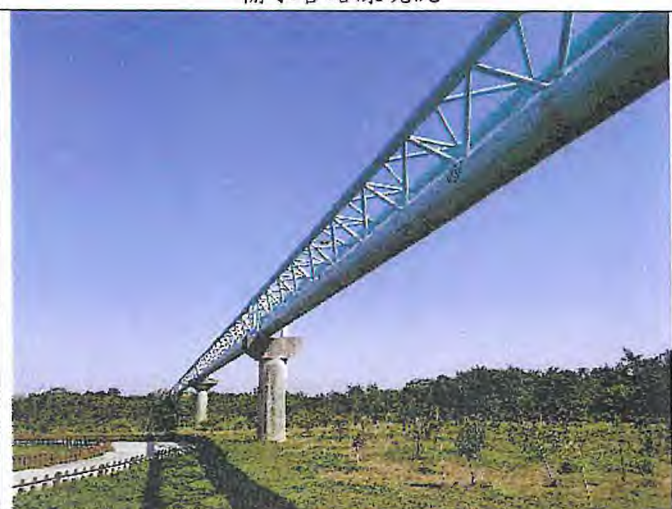
輸水管路線現況
