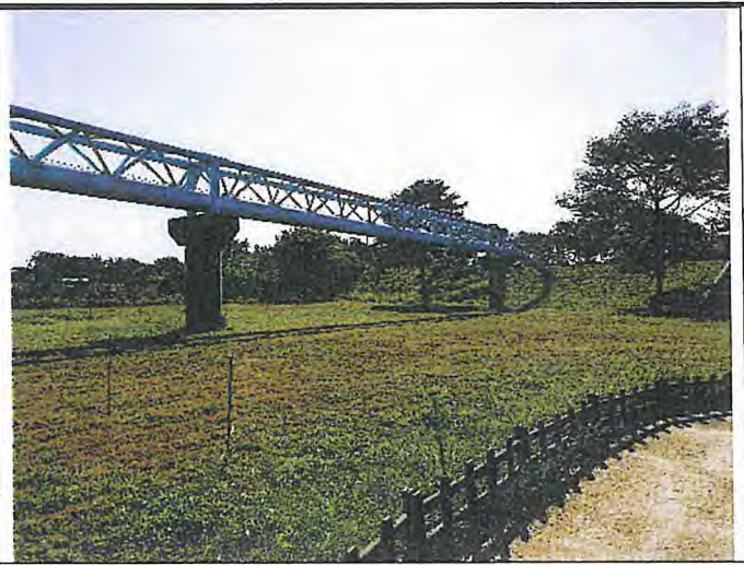
輸水管路線現況
