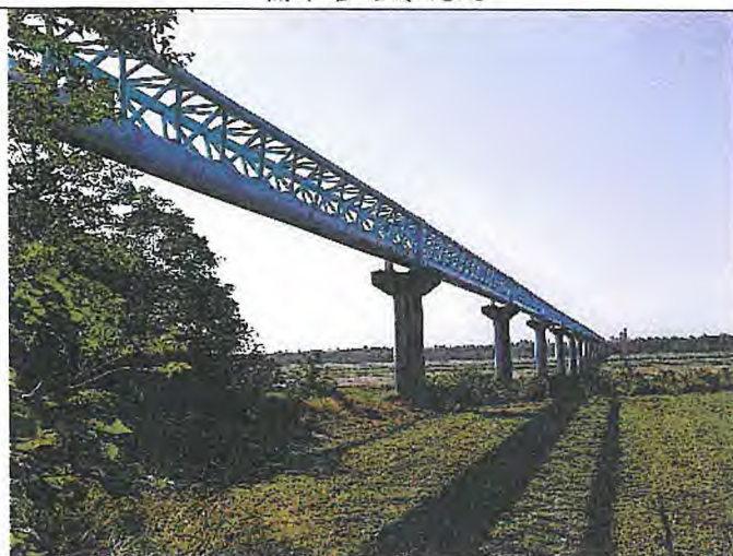
輸水管路線現況
