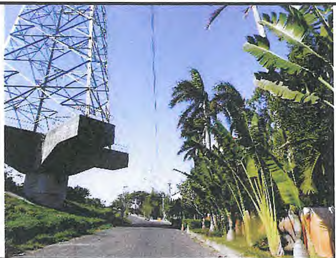
輸水管路線現況
