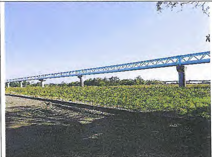
輸水管路線現況
