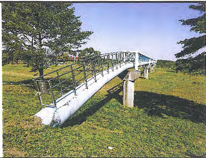
輸水管路線現況
