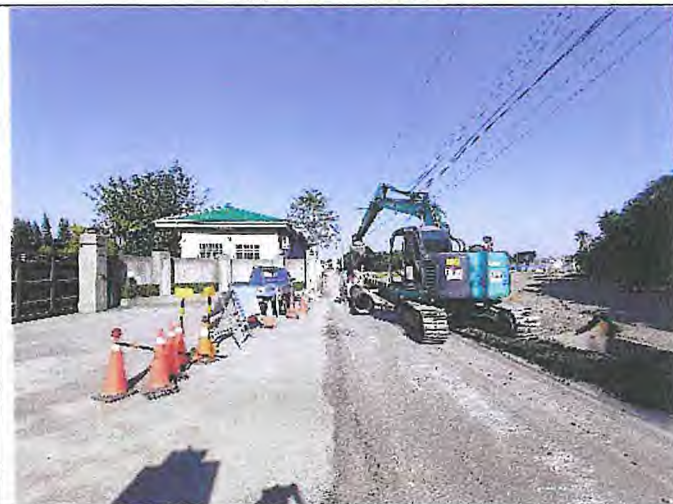
輸水管路線現況
