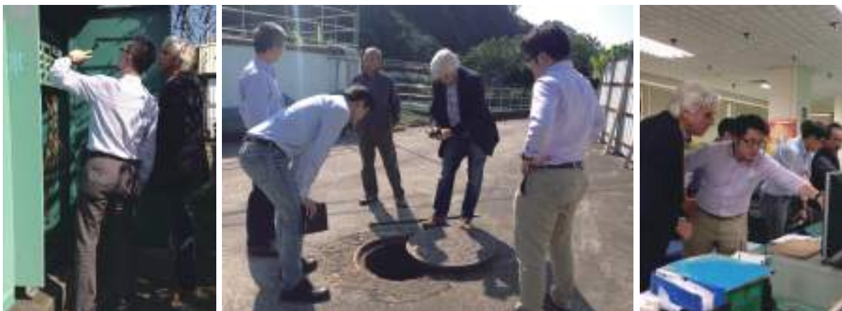
圖2-2-59 國際級專家團隊現地勘查本公司供水設備及監控系統
