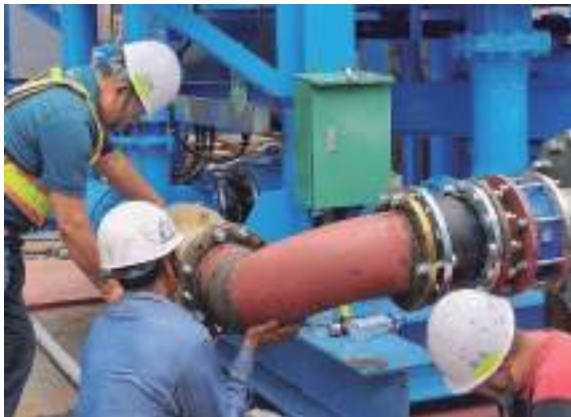
圖2-2-49 建築工地地下水取水現場，承商同心協力接管
