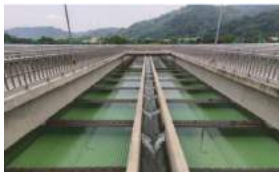
圖23 傾斜管過濾水源
