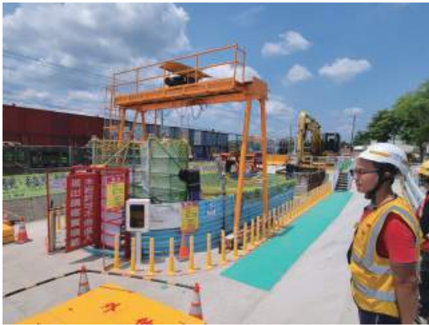
圖2-10-2 現地職安衛督導成效
