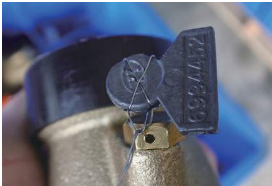
圖2-7-4 水量計鉛封確實
