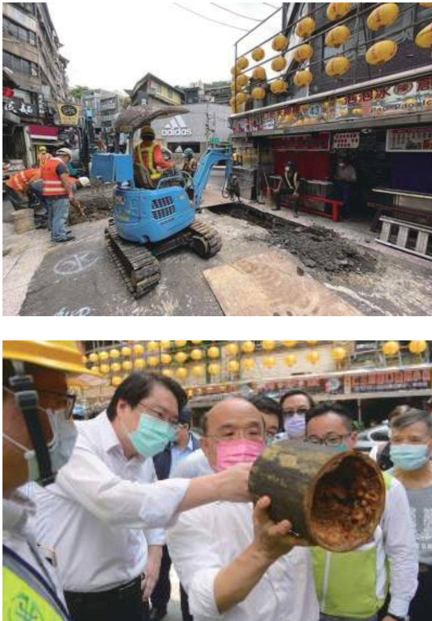
圖2-2-30 基隆廟口管線汰換施工與行政院蘇貞昌院長現場視察
