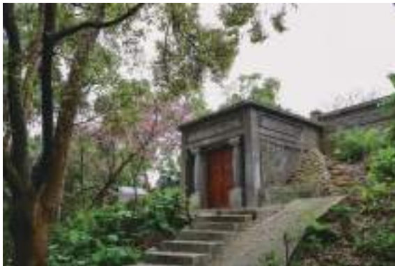
新北市定古蹟「瑞穗配水池」
