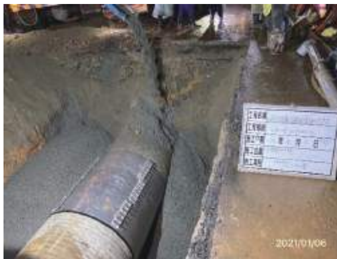
圖2-2-28 龜山系統1,200mm預力混凝土管(PSCP)破管以止漏帶包覆搶修
