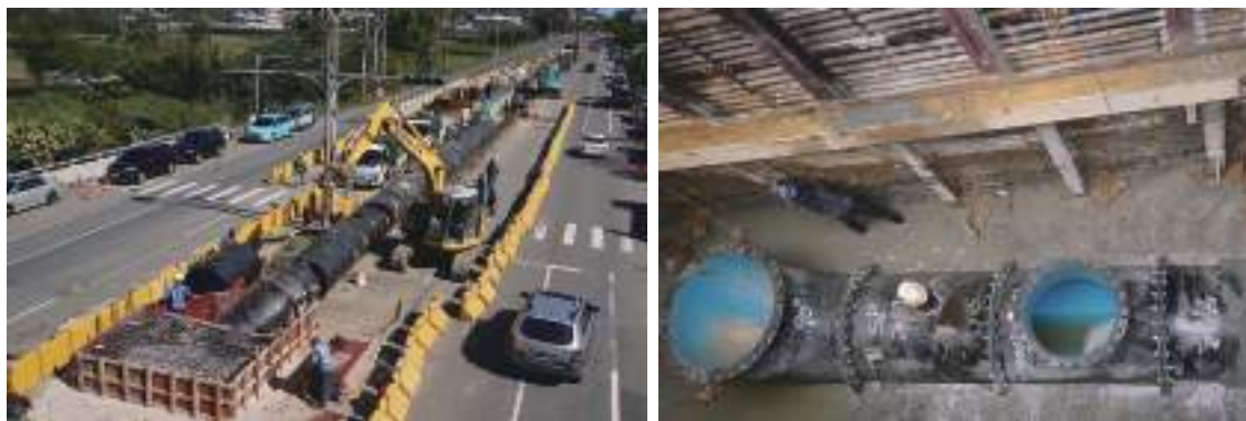
圖2-2-22 桃園新竹備援管線現場施工照片
