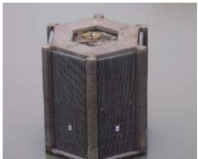
圖2-2-42 取水工導槽框更新與取水工攔污柵完成更新
