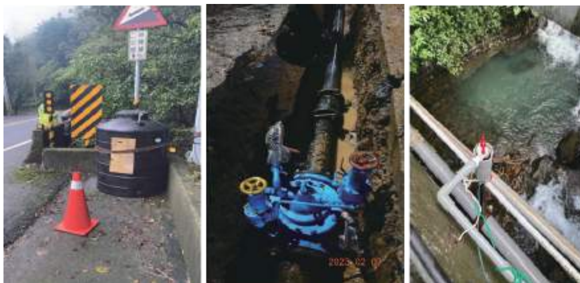
圖2-2-46 天籟路口湧泉100mmPVCP原水管改接及自噴井加藥設備建置
