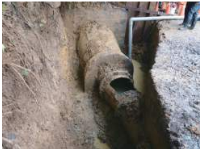
圖2-2-41 現場管溝清除
