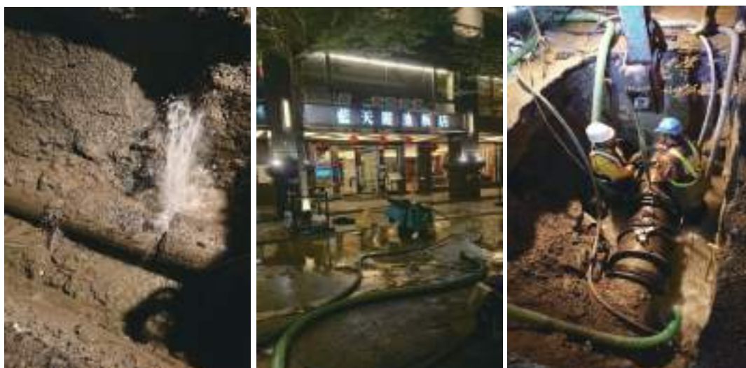
圖2-2-19 中正路400mm PSCP破管搶修
