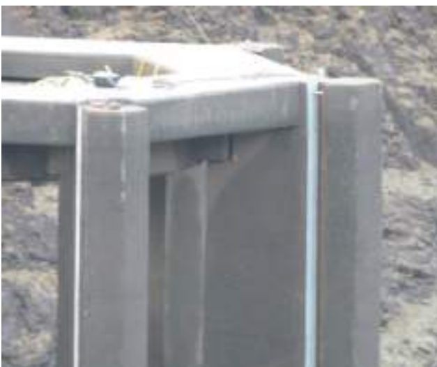
圖2-2-42 取水工導槽框更新與取水工攔污柵完成更新
