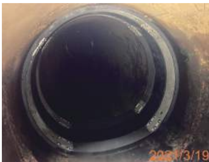
圖2-2-29 豐原區圓環東路900mm預力混凝土管(PSCP)破管以內套環搶修
