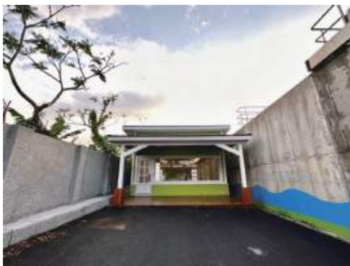
圖2-10-11 利嘉淨水場小水力發電電廠-外觀
