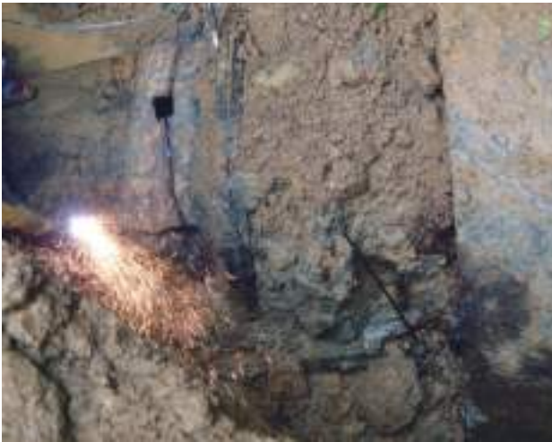
圖2-2-40 現場施工搶修(1100 →900搶修開孔)
