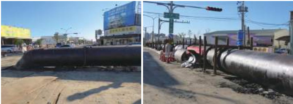
圖2-2-15 崑大路 \phi 1,350\text{m/m} 架設臨時明管
