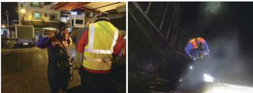
圖2-2-18 進行密閉空間檢漏作業
