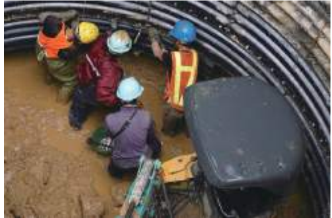
圖2-2-48 桃園-新竹備援管線工程施工現場，承商不畏泥濘加緊趕工
