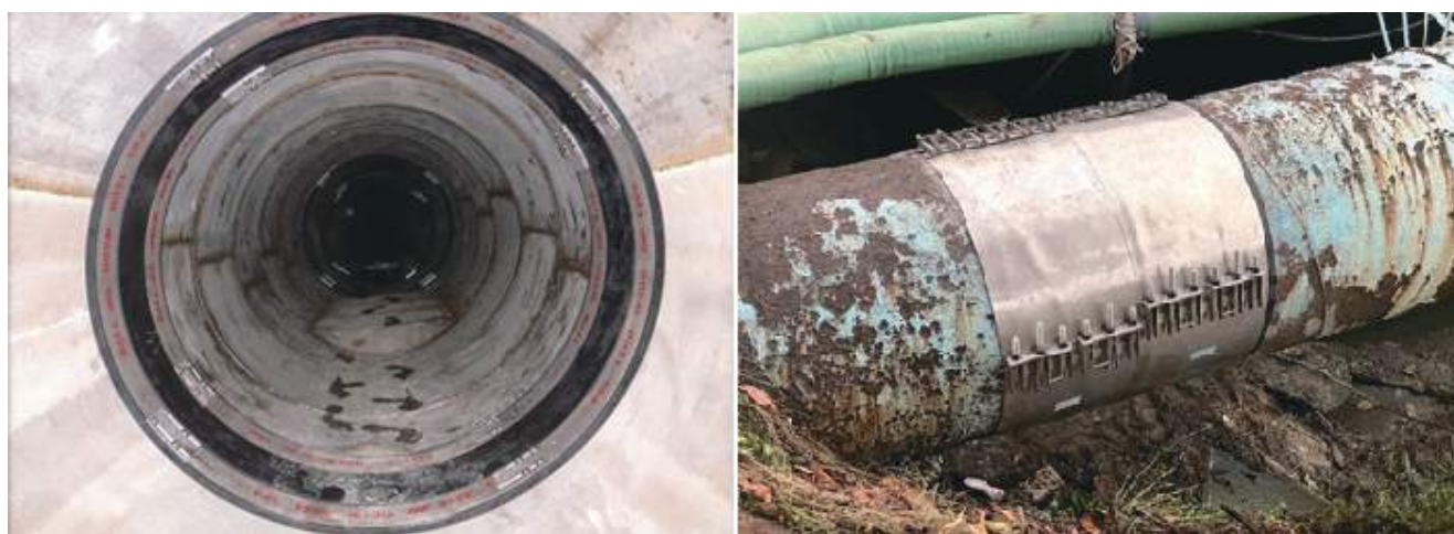
圖2-2-57 內套環與外套止漏夾修補
