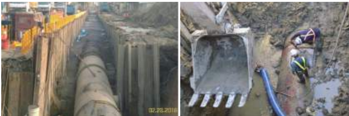
圖2-2-16 永大路 \phi 2,000\text{m/m} 幹管搶修
