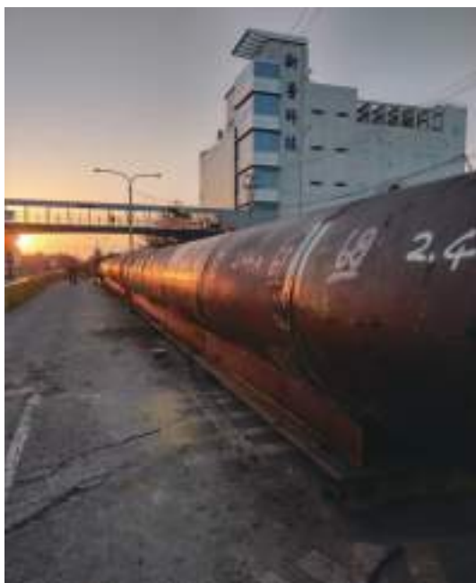
圖1-2-6 本工程管(六)-1埋設管線照片
