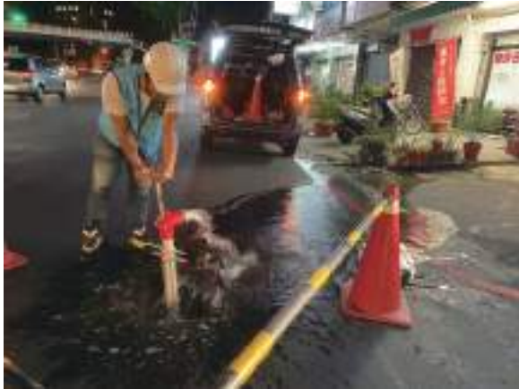
圖2-2-47 分區供水階段，夜間復水期間於路口進行排水、排氣作業
