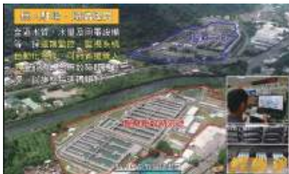
圖22 豐原新設初沉池
