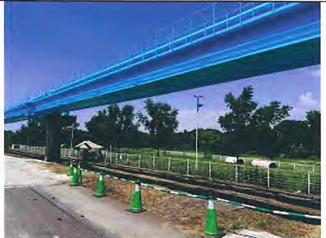
輸水管路線現況
