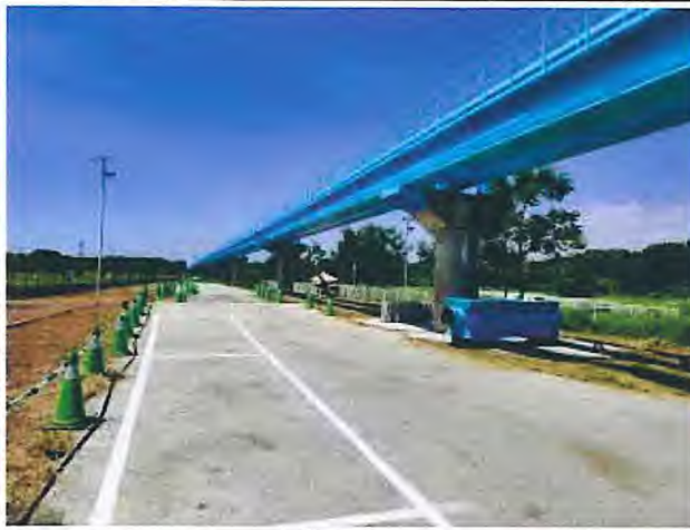
輸水管路線現況
