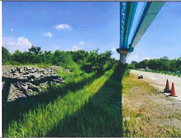
輸水管路線現況
