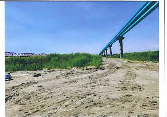
輸水管路線現況
