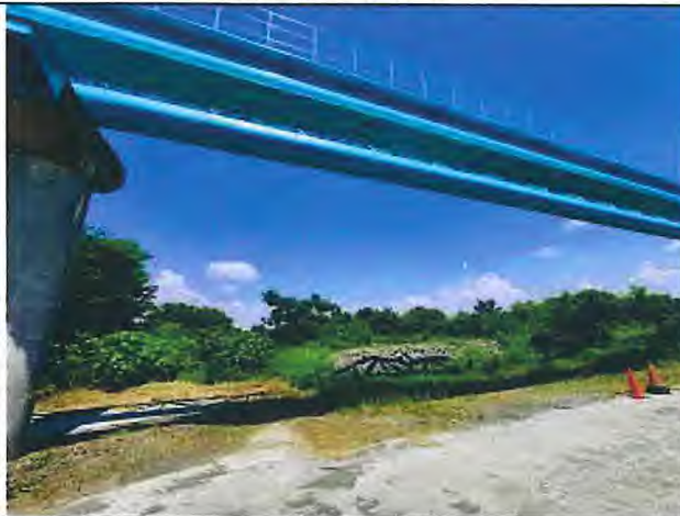
輸水管路線現況
