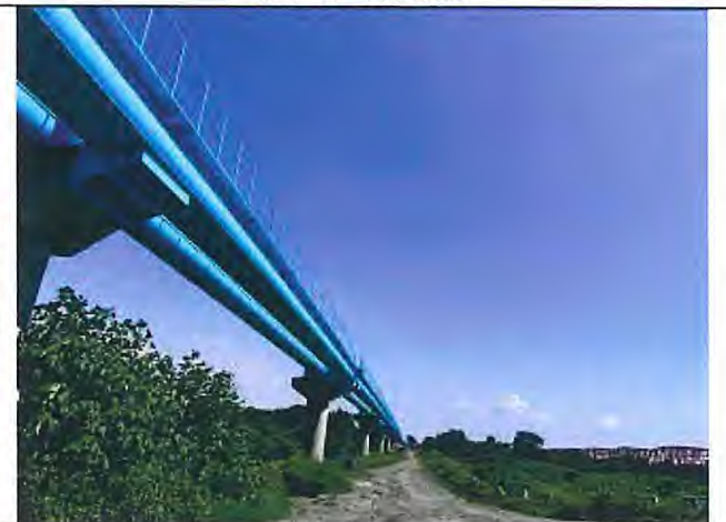
輸水管路線現況
