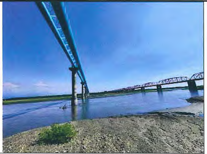
輸水管路線現況
