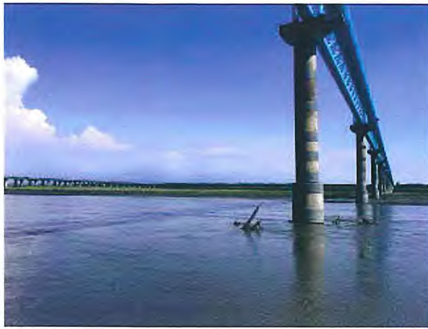
輸水管路線現況
