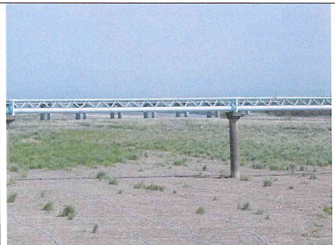
輸水管路線現況
