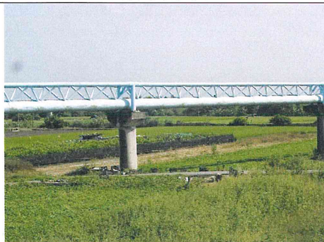
輸水管路線現況
