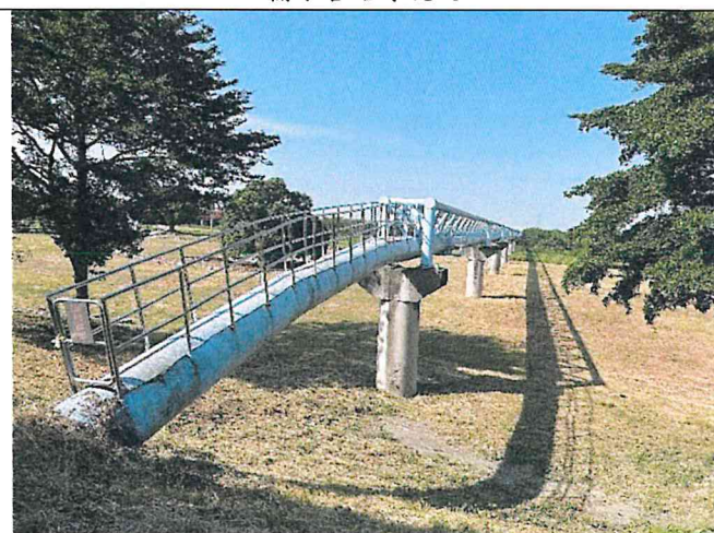
輸水管路線現況
