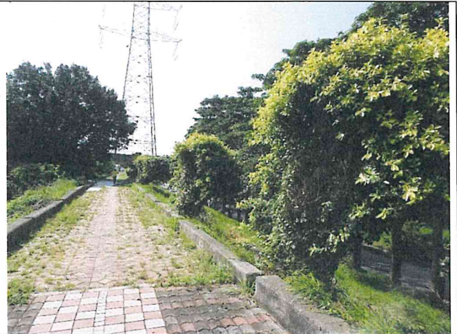
輸水管路線現況
