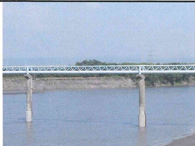
輸水管路線現況
