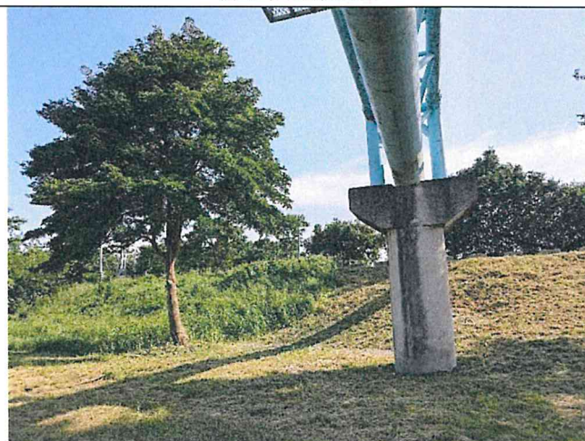
輸水管路線現況
