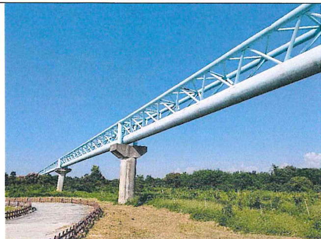
輸水管路線現況
