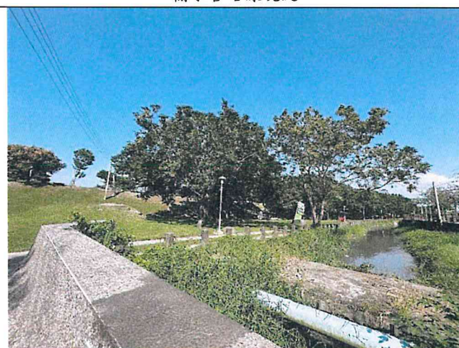
輸水管路線現況
