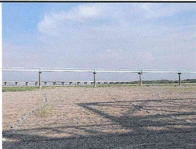
輸水管路線現況
