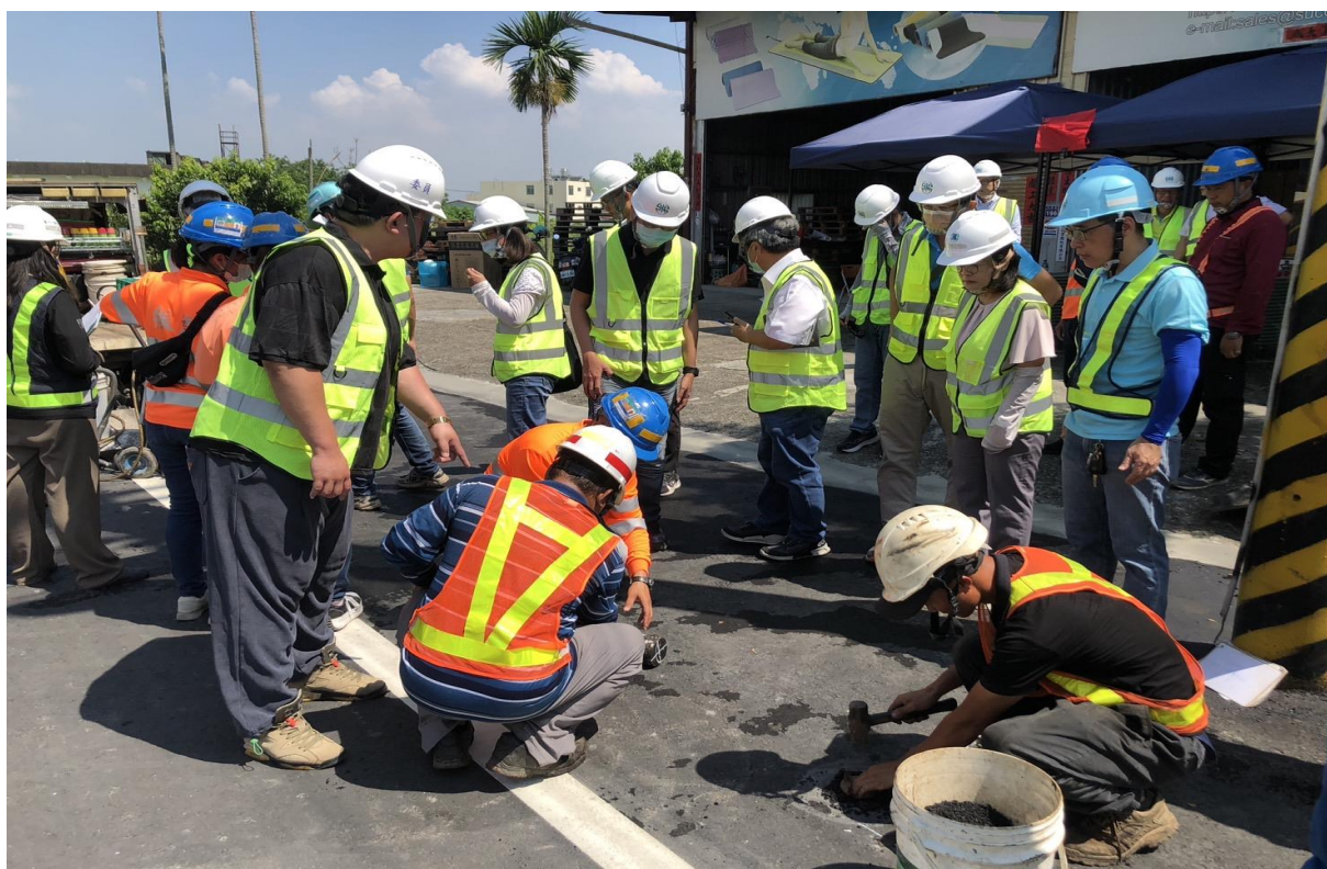
查核工程名稱：芬園鄉茄荖村延管工程(一)暨花壇所芬園鄉茄荖村(一)延管新裝工程
