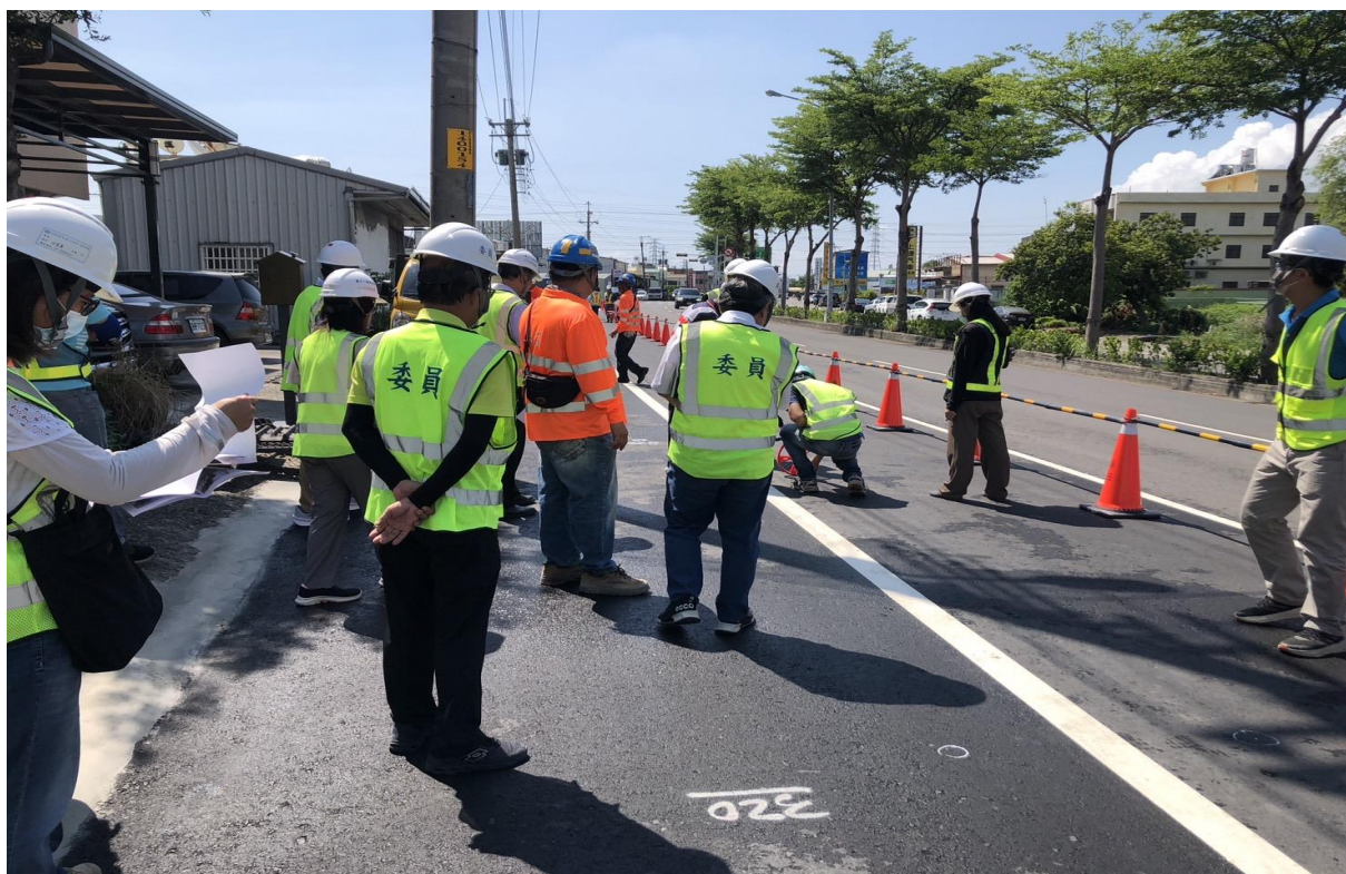
查核工程名稱：芬園鄉茄荖村延管工程(一)暨花壇所芬園鄉茄荖村(一)延管新裝工程
