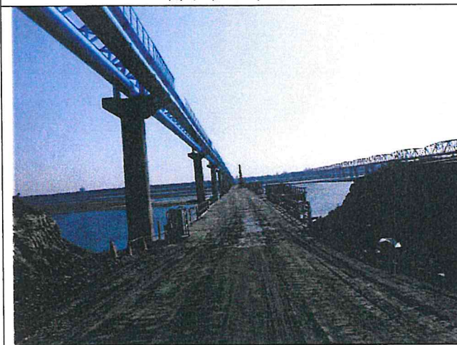
輸水管路線現況
