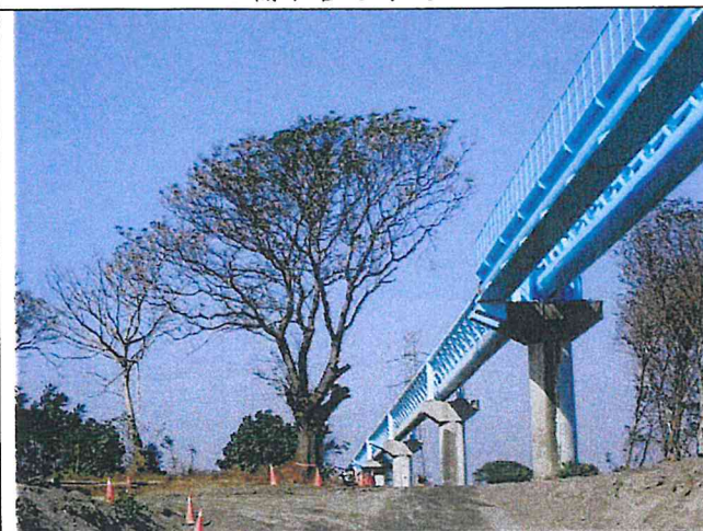
輸水管路線現況
