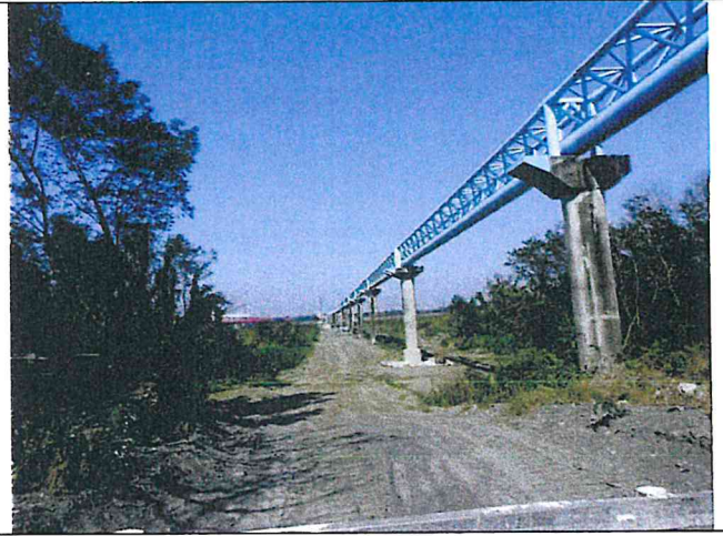
輸水管路線現況
