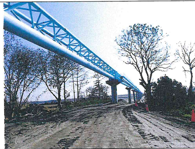
輸水管路線現況
