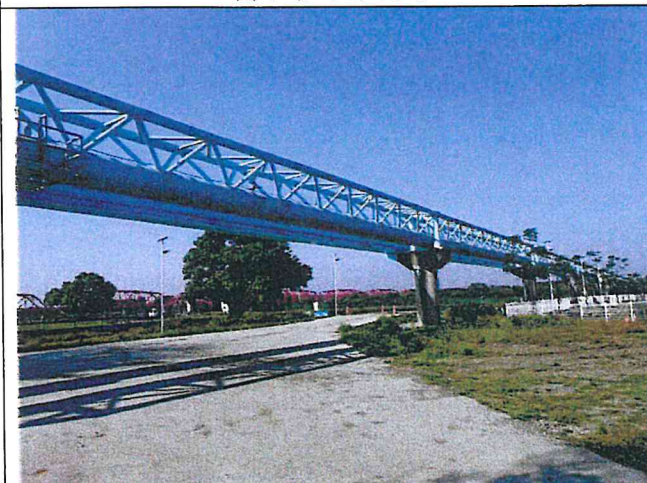
輸水管路線現況
