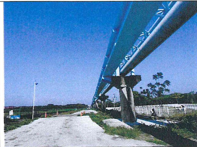
輸水管路線現況
