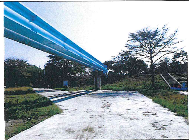
輸水管路線現況
