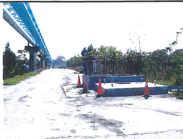
輸水管路線現況
