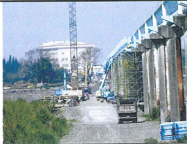
輸水管路線現況
