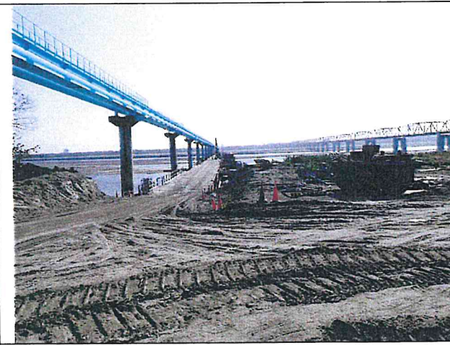
輸水管路線現況
