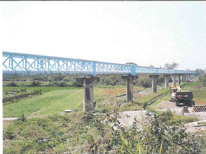
輸水管路線現況
