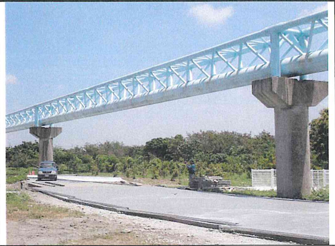
輸水管路線現況
