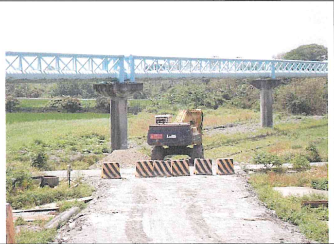
輸水管路線現況
