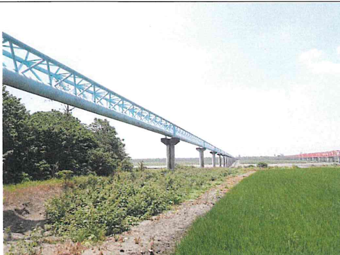
輸水管路線現況
