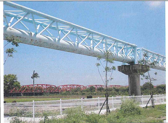
輸水管路線現況
