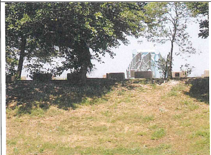
輸水管路線現況
