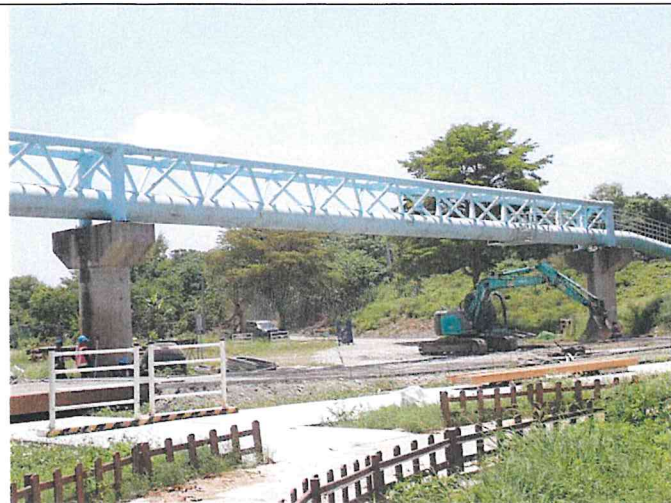
輸水管路線現況
