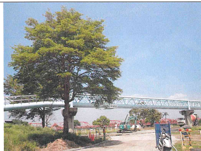
輸水管路線現況
