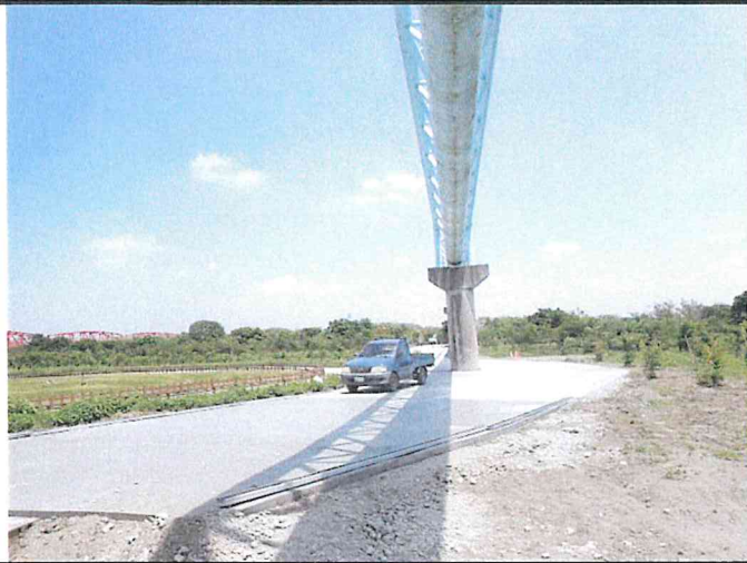
輸水管路線現況
