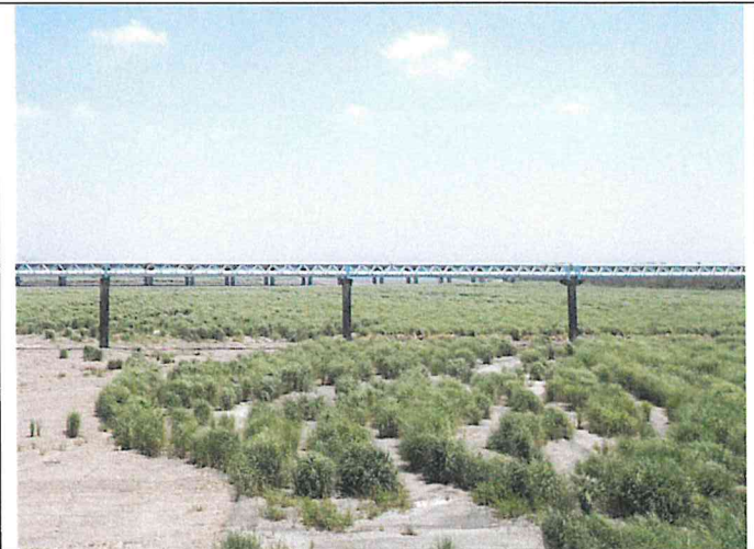
輸水管路線現況
