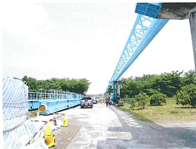
輸水管路線現況
