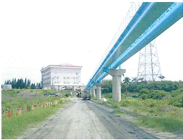
輸水管路線現況
