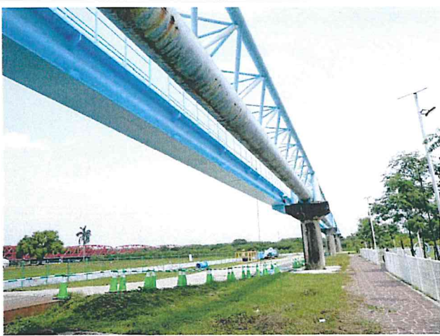
輸水管路線現況
