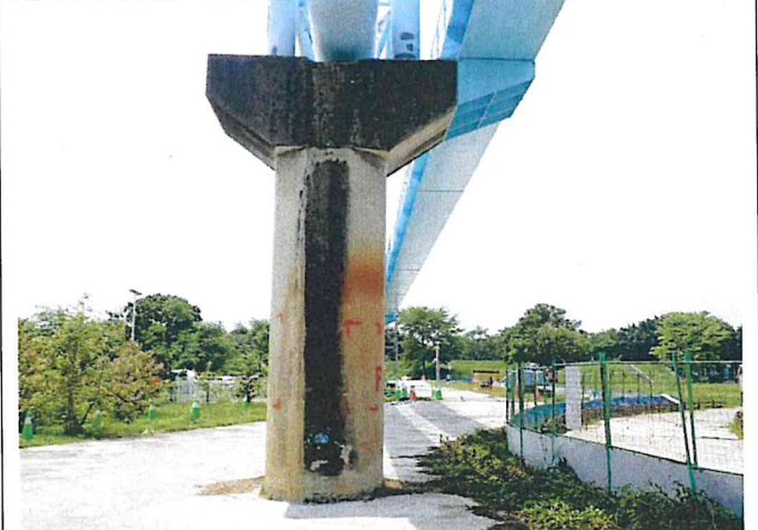
輸水管路線現況
