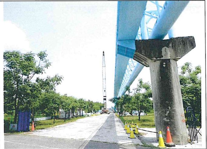
輸水管路線現況
