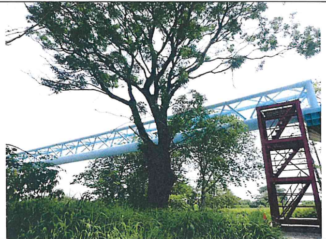
輸水管路線現況
