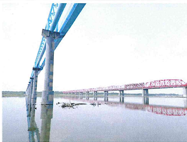
輸水管路線現況
