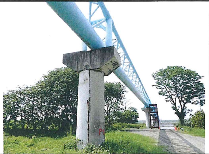
輸水管路線現況
