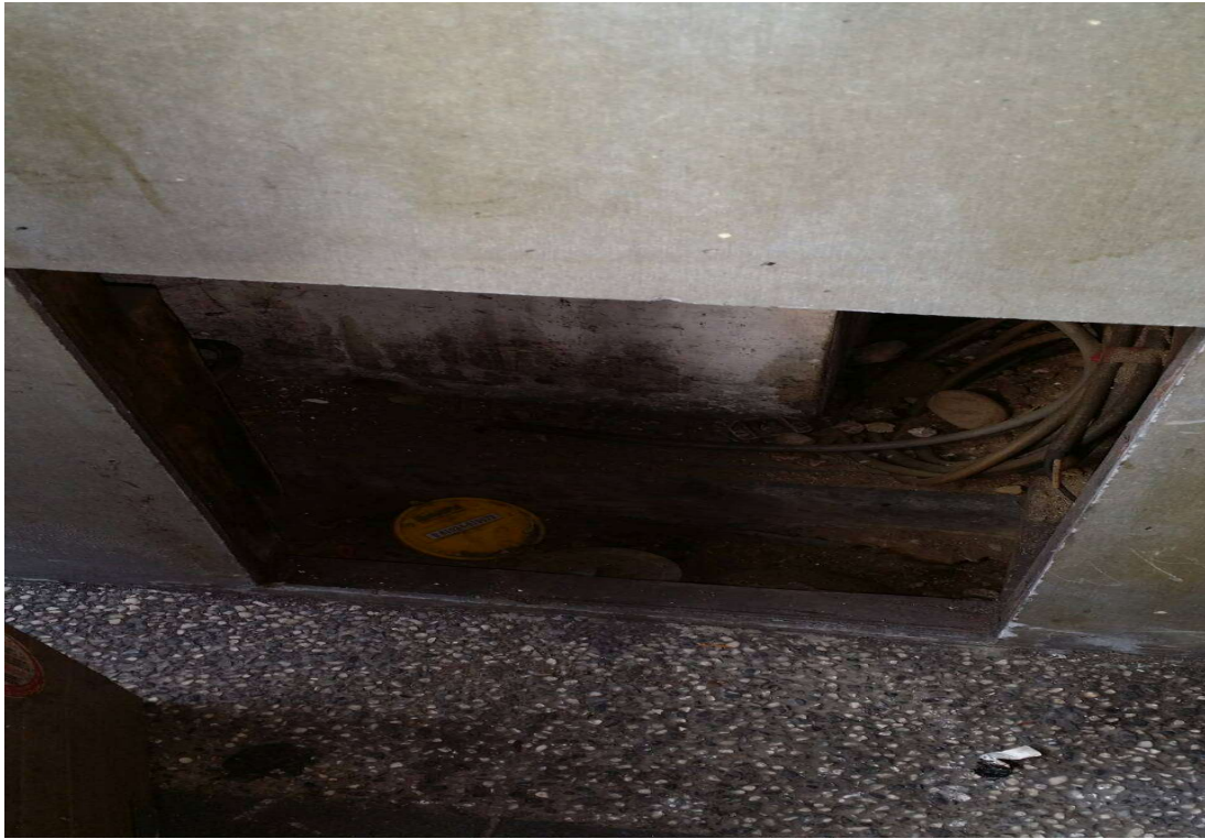
圖(6)用戶因裝潢將水表包在牆柱招牌中，且表位不正與用戶協商後表位遷移後進行汰換。
