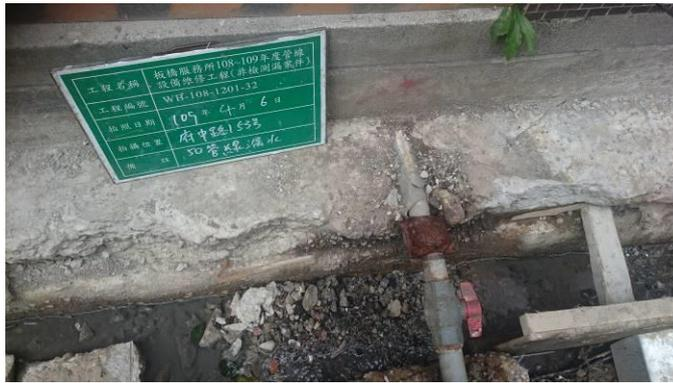
(圖 8: 原自來水管鏽蝕破漏)
