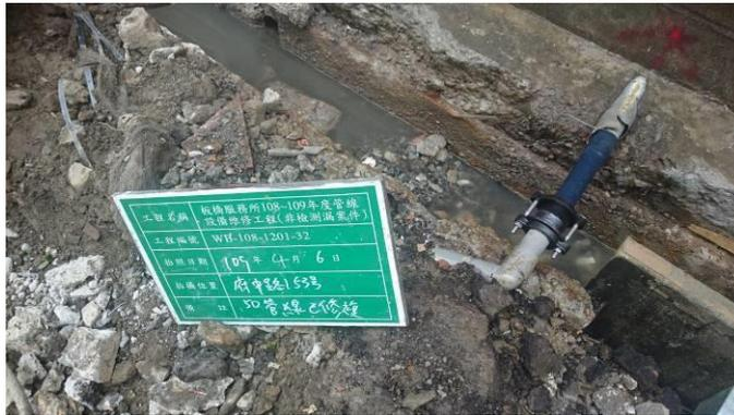
(圖 9: 更換此段管線+伸縮接頭)
