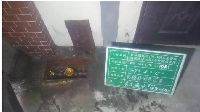
(圖 2: 直接更換止水栓)
