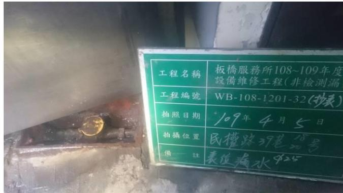
(圖 1: 止水栓過於老舊無法鎖緊)
