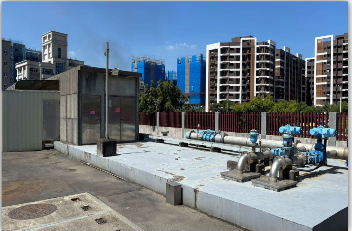
A10 站配水池
