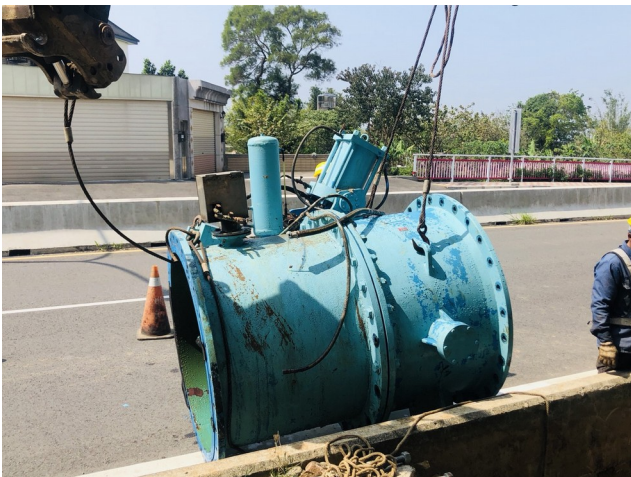
\phi 1200緊急遮斷閥拆除照片
