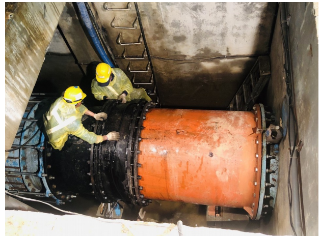
完工現場照片
