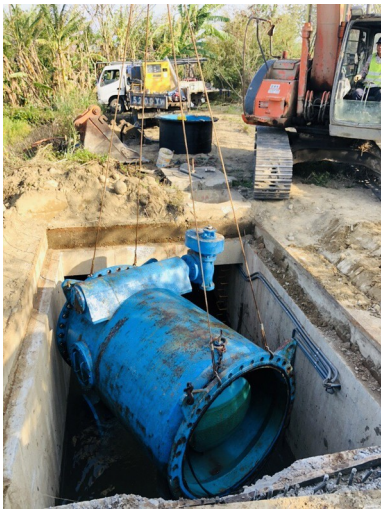
\phi 1350錐形流量控制閥拆除照片
