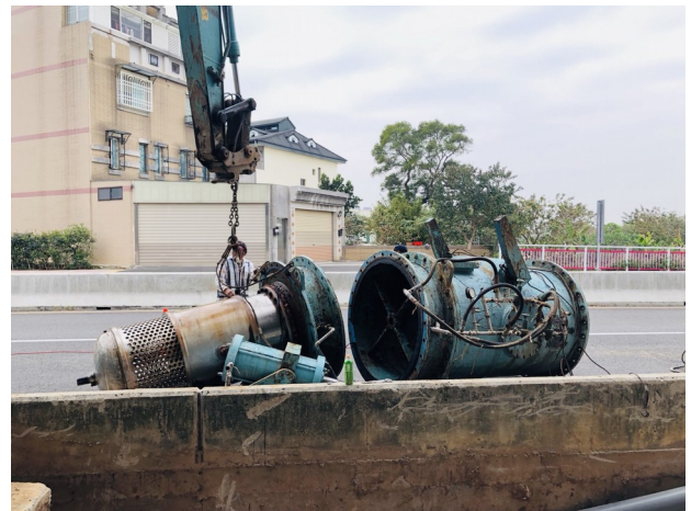
\phi 1200多噴孔持減壓閥拆除照片
