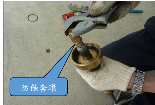
(十字鑽孔機裝置及施工)
