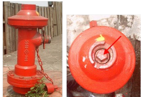
測量標的：消防栓 測點位置：消防栓頂外型柱中心點
