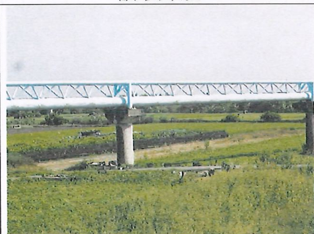
輸水管路線現況
