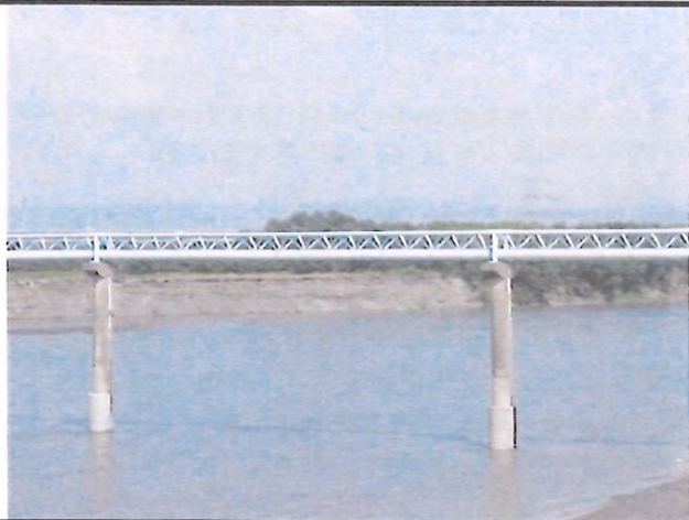
輸水管路線現況
