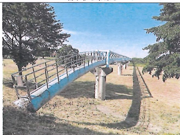
輸水管路線現況
