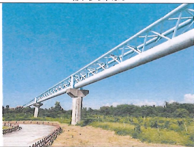
輸水管路線現況
