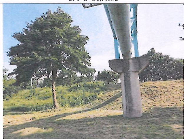
輸水管路線現況
