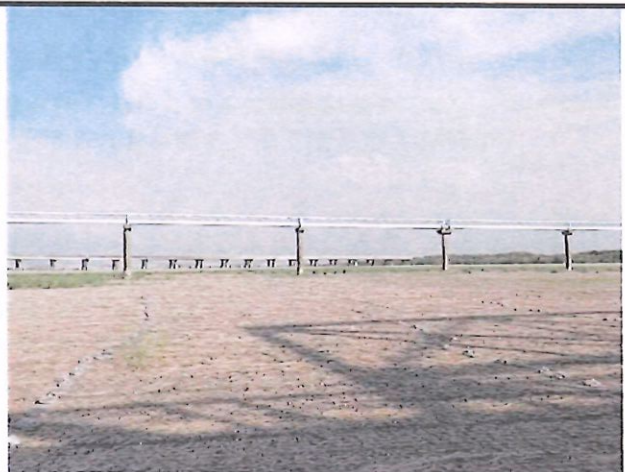
輸水管路線現況
