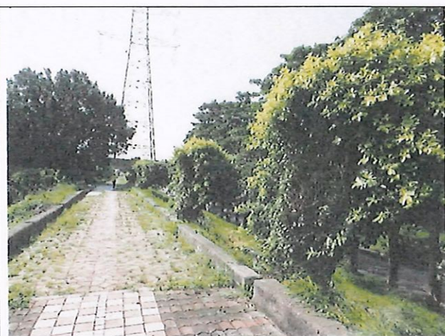
輸水管路線現況
