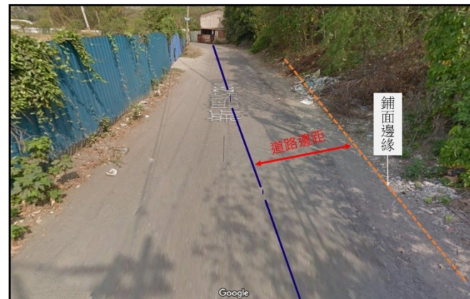
圖十二、無邊溝，道路邊緣不明顯，仍應確認鋪面邊緣，並以「鋪面邊緣線」作為量測基準。
