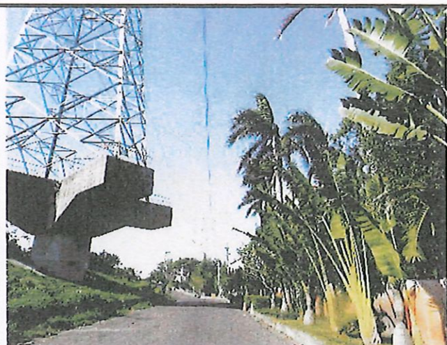
輸水管路線現況
