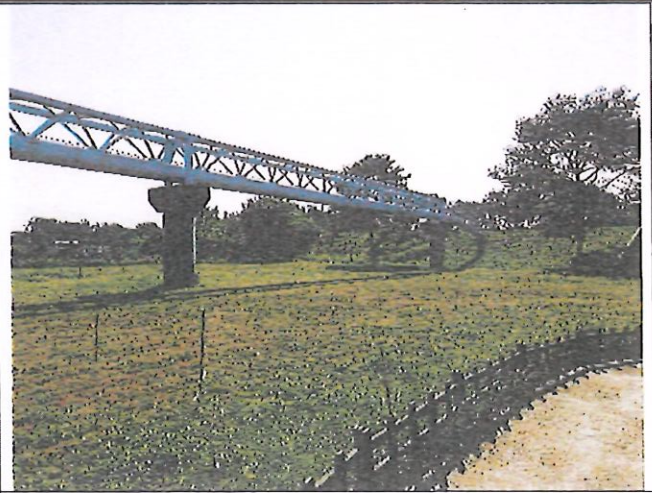
輸水管路線現況
