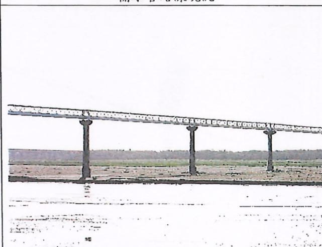
輸水管路線現況
