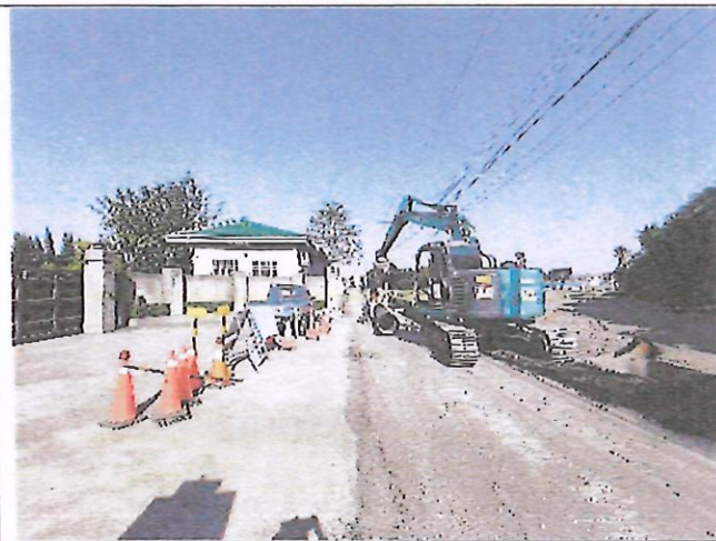
輸水管路線現況
