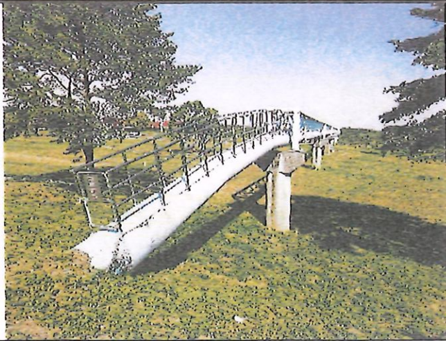
輸水管路線現況
