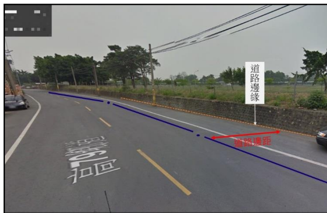
圖八、無邊溝，無人行道，道路邊緣明顯，以「路邊緣線」為量測基準。
