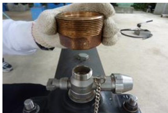
(安裝接合器於鞍帶分水栓上)
