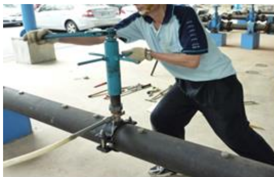
(十字鑽孔機施工及排水)
