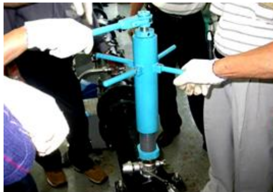
(十字鑽孔機裝置及施工)
