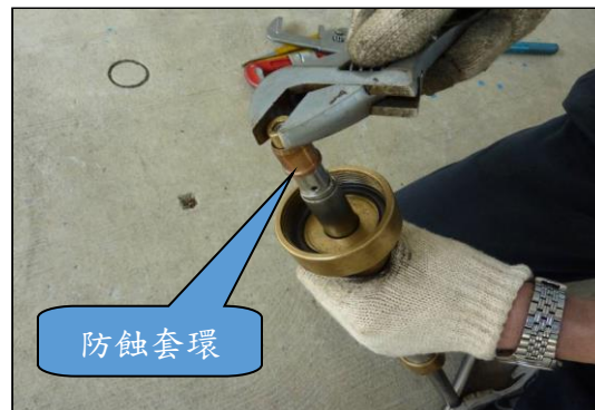
(十字鑽孔機裝置及施工)
