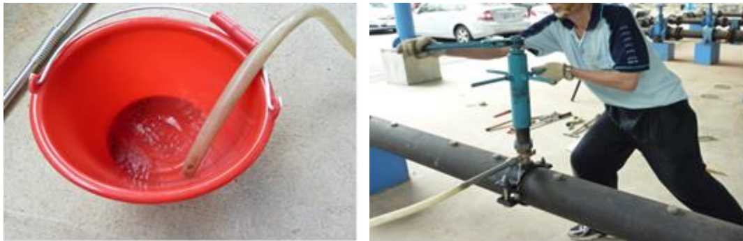
(十字鑽孔機施工及排水)
