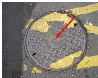
測量標的：自來水圓形人孔 測點位置：人孔中央[台水]圓形交叉點
