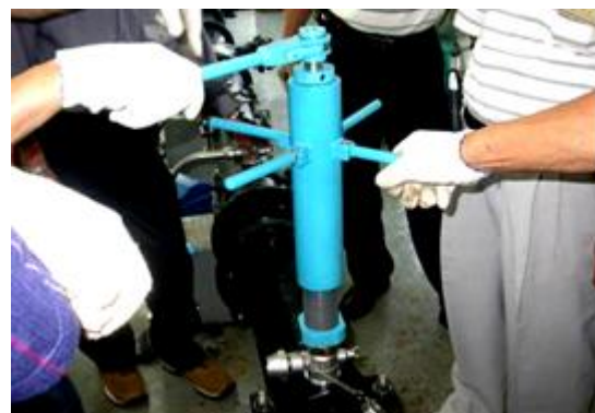
(十字鑽孔機裝置及施工)
