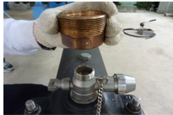
(安裝接合器於鞍帶分水栓上)
