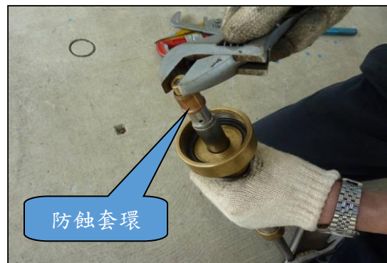
(十字鑽孔機裝置及施工)
