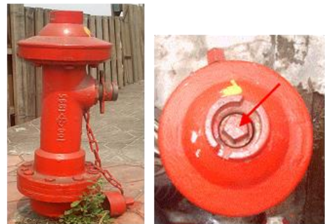
測量標的：消防栓 測點位置：消防栓頂方型柱中心點
