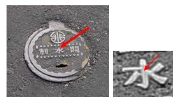
測量標的：圓型制水閘 測點位置：人孔中央[制水閘箱]方形標示[水]字中央處
