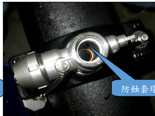
(防蝕套環裝置完成)
