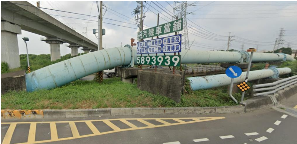
圖 1 下甲橋水管橋現況
