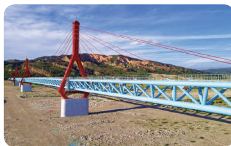
大安溪新設水管橋工程
