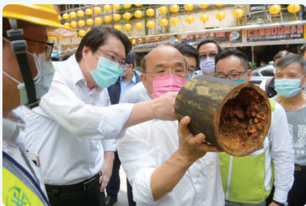
行政院長視察廟口管線汰換工程
