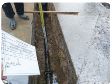
新北市瑞芳區上天裡大寮路供水 延管工程 - 埋管照片
