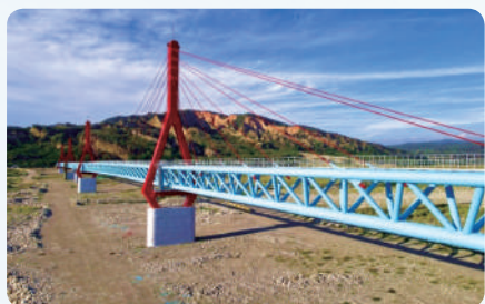
大安溪新設水管橋工程現場照片
