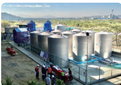
後龍溪伏流水完工現場
