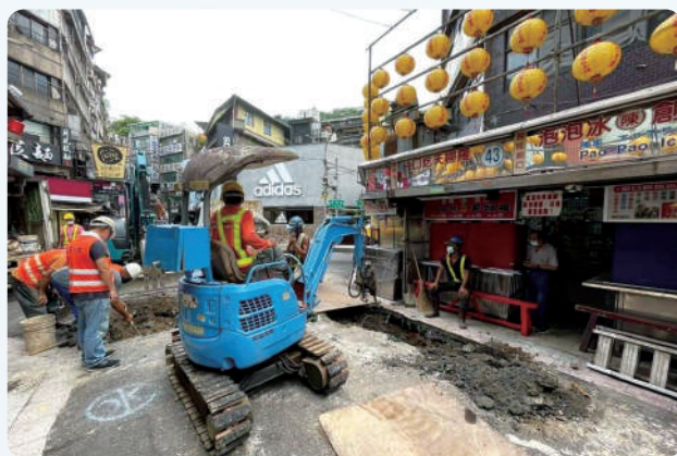
廟口管線汰換工程施工
