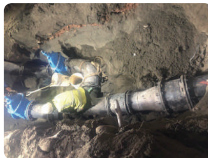
台中港緊急海淡廠施工現場
