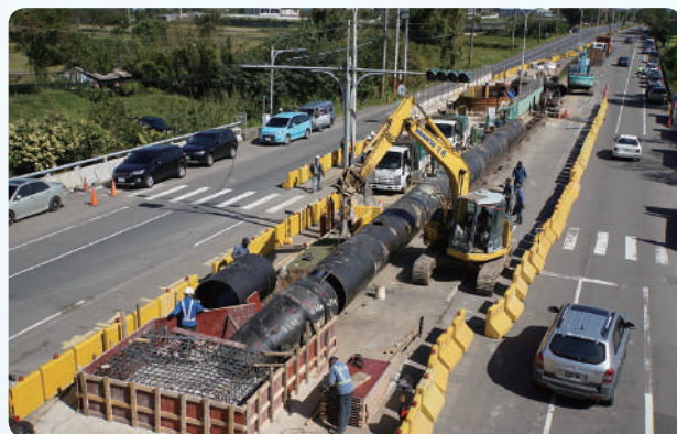
桃園 - 新竹備援管線工程
