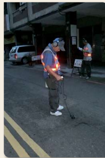
測漏器聽音檢漏作業
