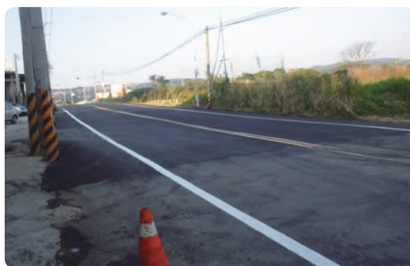
路面回復完成
