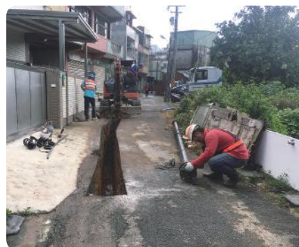
楊梅區永平里中山北路二段 366 巷 26 號等供水延管工程
