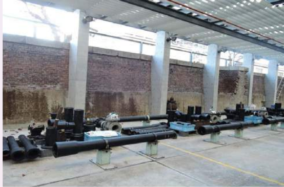
小口徑管線裝接訓練場
