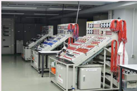
儀器設備及電氣實習場
