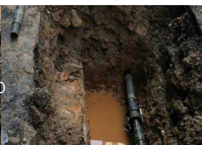
破漏點斷管後裝接情形
