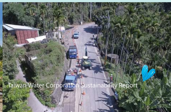
延管工程施工照片
