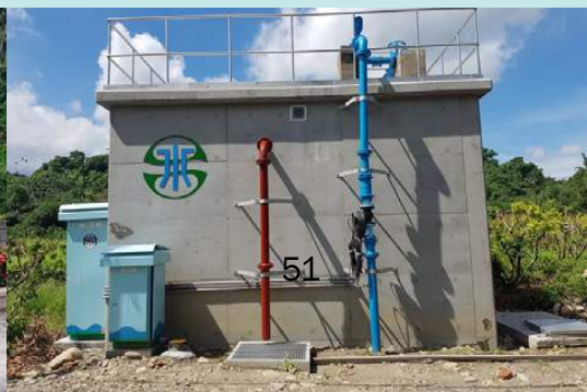
雲林縣古坑鄉石坑地區延管工程
