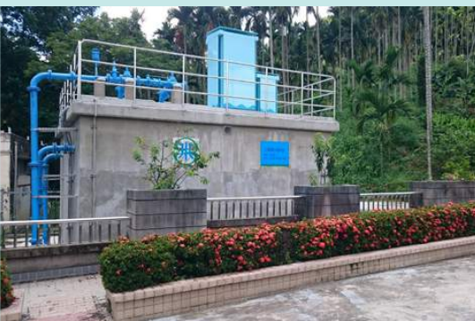
中埔鄉三層村自來水延管工程
