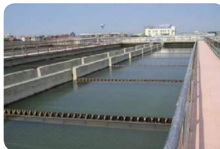
傳統式(水平流式)沉澱池
