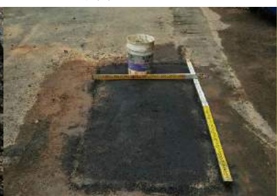
施工坑回填後柏油路面鋪設
