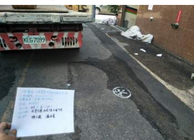
檢測地下漏水位置標示
